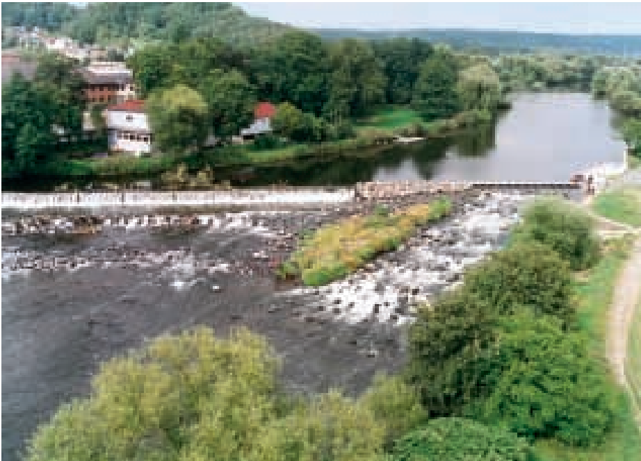
Bild 1: Wehr in Siegburg-Buisdorf mit Fischaufstiegsrampe, Kontroll- und Fangstation für Fische (Foto: E. Städtler)
