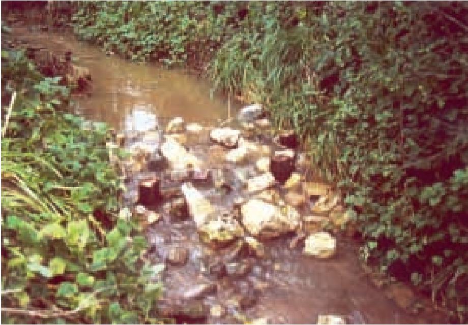
Bild 3: Einbau der Sohlenschwelle in einen strukturarmen, tiefererodierten Gewässerabschnitt (Foto: H. Hellwig)
