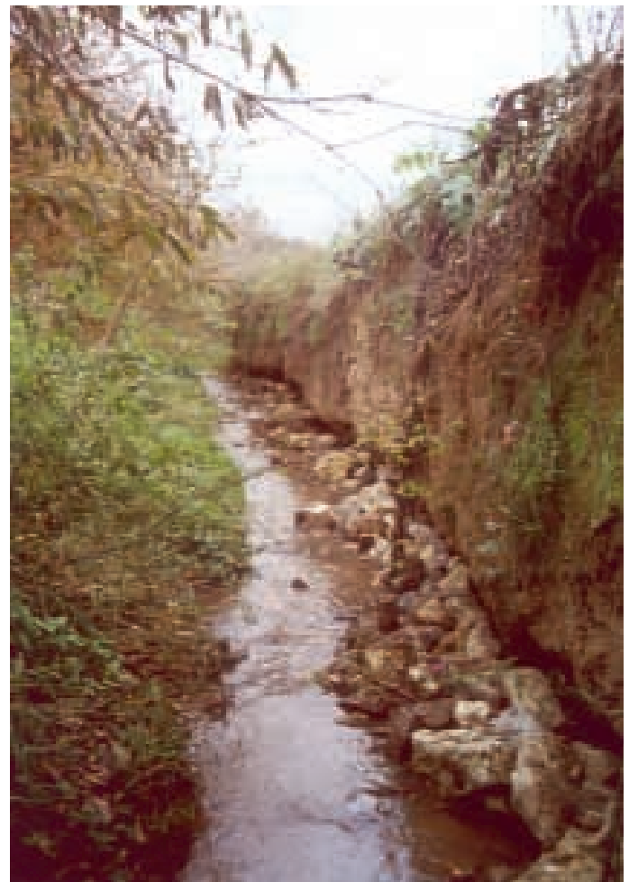
Bild 4: Sicherung des Steilufers durch künstliche Längsstrukturen mit Pfahlsicherung (Foto: H. Hellwig)
