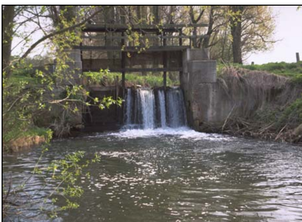
Abb. 90: Durchgängigkeit: Links Wanderungsbarriere durch das Wehr an der Gartemühle; rechts Umgehungsgewässer in Form eines Blocksteinbeckenpasses.
