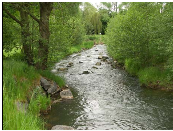
Abb. 89: Durchgängigkeit: Links Wanderungsbarriere durch die Wehranlage Steinsmühle in der Garte (1994); rechts zur Sohlgleite umgebaute Wehranlage mit Schwarzerlen-Sukzession auf den Böschungen (2008).
