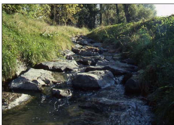
Abb. 90: Durchgängigkeit: Links Wanderungsbarriere durch das Wehr an der Gartemühle; rechts Umgehungsgewässer in Form eines Blocksteinbeckenpasses.
