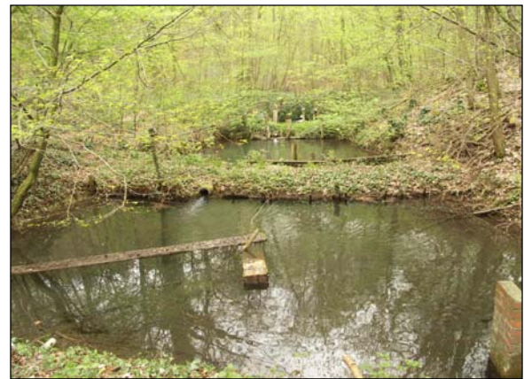
Abb. 87: Durchgängigkeit: Links Wasserentnahme mit Überlauf aus einer verbauten Quelle; rechts Verbau des Abflusses durch Fischteiche.
