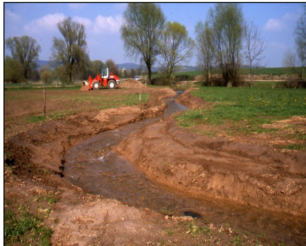
Abb. 69: Vorstrukturiertes neues Bachbett; Ende Februar 2002.
