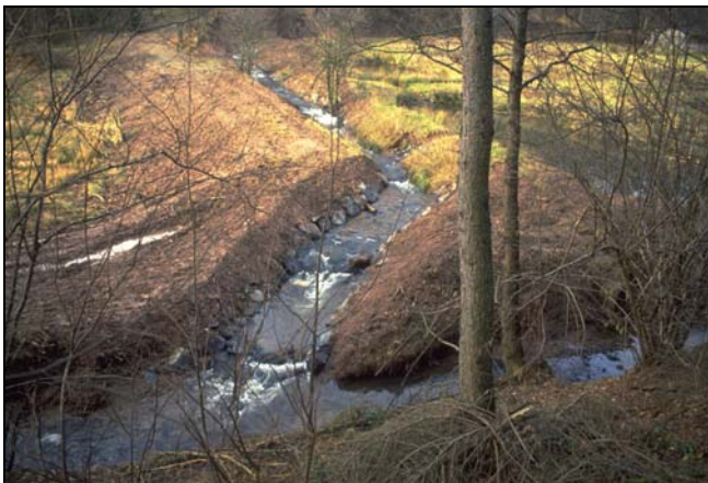
Abb. 92: Durchgängigkeit: Links neu gebautes Umgebungsgewässer um eine Teichanlage im Oberlauf der Bever (1994); rechts naturnahe Entwicklung des Umgebungsgewässers nach vier Jahren (1998).
