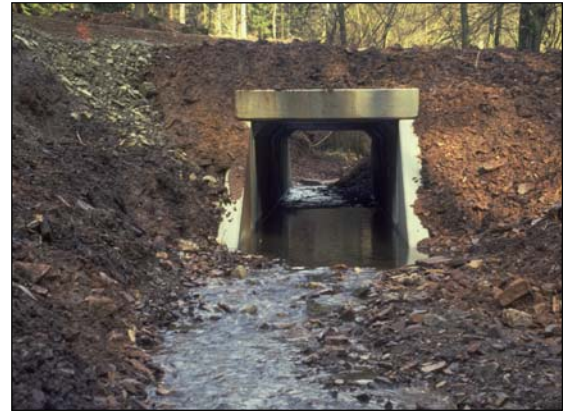
Abb. 91: Durchgängigkeit: Links Rahmendurchlass mit Absturz in der Bever im Waldgebiet des Elfas (1994); rechts Ersatz des alten durch einen neuen Rahmendurchlass, sohlgleich abgesenkt und am Ausfluss mit rauer Sohlgleite versehen (1995).
