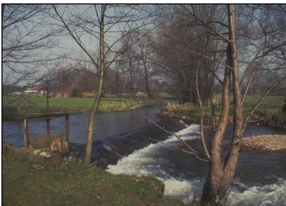
Abb. 93: Durchgängigkeit: Links Sohlabsturz in der Ilme zur Wasserableitung in ein Kraftwerk; rechts nahezu trocken gefallener Flussabschnitt der Ilme unterhalb der Wasserableitung (Sommer 2008).
