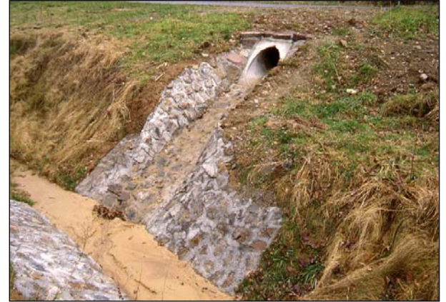
Abb. 101: Reduktion der Stoffeinträge: Links Einträge von Feinsediment und Nährstoffen durch Entwässerungsgräben aus dem landwirtschaftlichen Einzugsgebiet der Bever (1998); rechts verrohrter Zuflussgraben mit Feinsedimenteintrag aus dem Einzugsgebiet in die Aue – Seeanger 1987.
