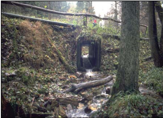
Abb. 91: Durchgängigkeit: Links Rahmendurchlass mit Absturz in der Bever im Waldgebiet des Elfas (1994); rechts Ersatz des alten durch einen neuen Rahmendurchlass, sohlgleich abgesenkt und am Ausfluss mit rauer Sohlgleite versehen (1995).
