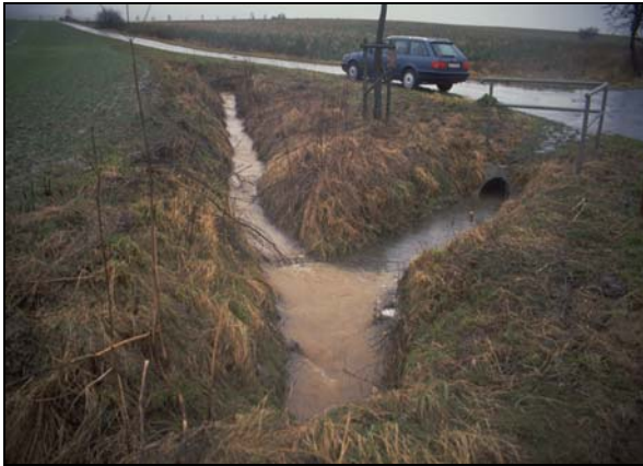
Abb. 101: Reduktion der Stoffeinträge: Links Einträge von Feinsediment und Nährstoffen durch Entwässerungsgräben aus dem landwirtschaftlichen Einzugsgebiet der Bever (1998); rechts verrohrter Zuflussgraben mit Feinsedimenteintrag aus dem Einzugsgebiet in die Aue – Seeanger 1987.
