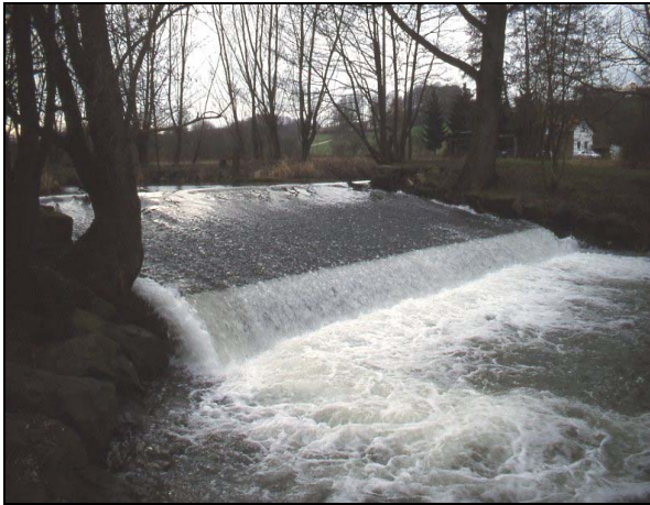
Abb. 88: Durchgängigkeit: Links unüberwindbarer Sohlabsturz am Leinewehr bei Friedland; rechts Aufhebung der Barrierewirkung durch Bau eines Umgehungsgewässers.
