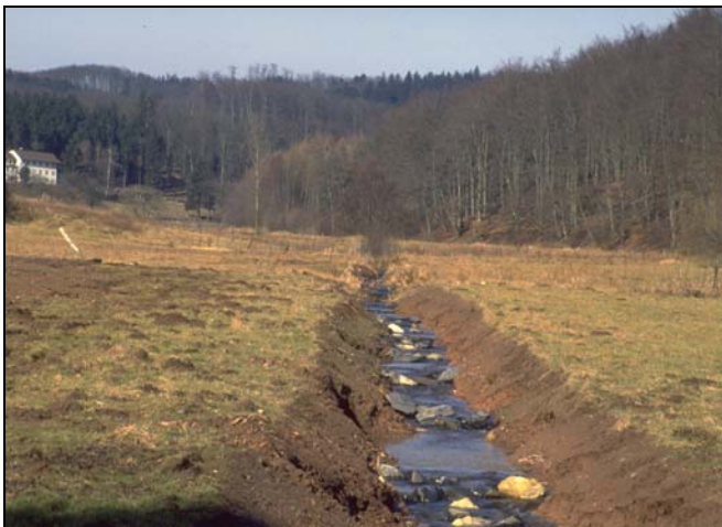
Abb. 77: Zulassen eigendynamischer Entwicklung in einem Mittelgebirgsbach am Beispiel der Bever: Links ehemals verrohrter Bachlauf in der Talmitte, 1994 geöffnet und vorstrukturiert; rechts Entwicklung nach vier Jahren (1998).
