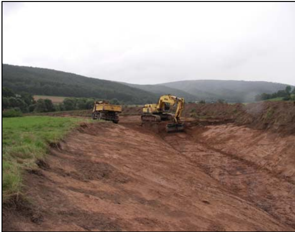
Abb. 74: Zulassen eigendynamischer Entwicklung in einem Mittelgebirgsbach am Beispiel der Nieme: Links Bau des neuen Bachlaufes, September 2006; rechts erste eigendynamische Entwicklungen durch Ausbildung einer Auelehmbank, November 2006.
