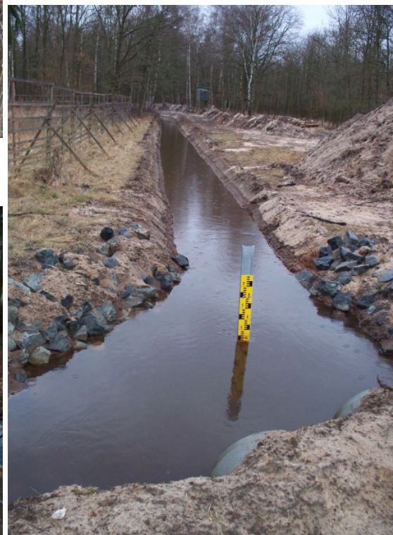
● Zuleitung zum Wulbeckgraben
