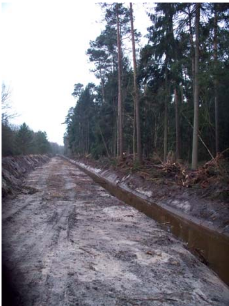
Abb.3 Zuleitungsgraben (Blick nach SE)
