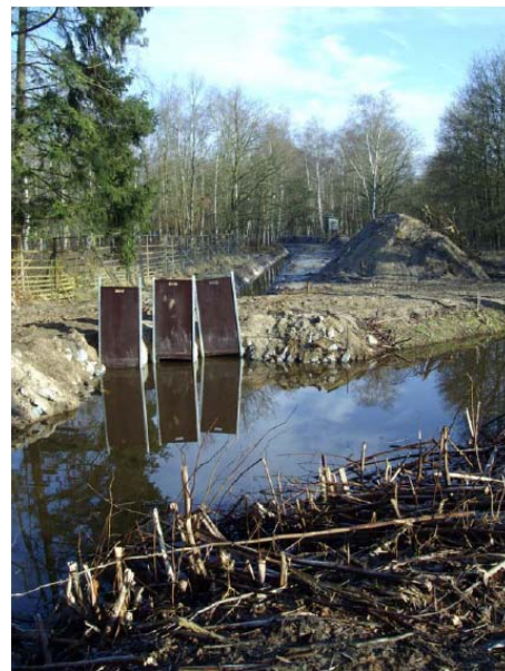
Abb.2 Überleitung zum Zuleitungs- graben(Blick nach NE)
