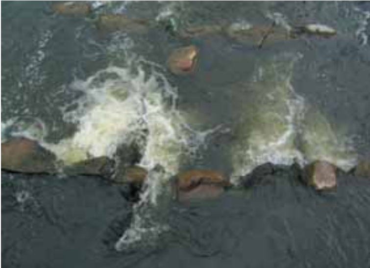
Foto 8: Starke Turbulenzen in dem Beckenbereich unterstrom eines durchgehenden Querriegels einer Sohlgleite in Riegelbauweise. Die Ursache liegt in einer hohen Wasserspiegeldifferenz und in dem Flaschenhalseffekt der Lücken zwischen Riegelblöcken. Die Turbulenzen verkleinern die Ruhebereiche in den Becken, erschweren die Orientierung von Fischen sowie die Passierbarkeit der Lücken.
