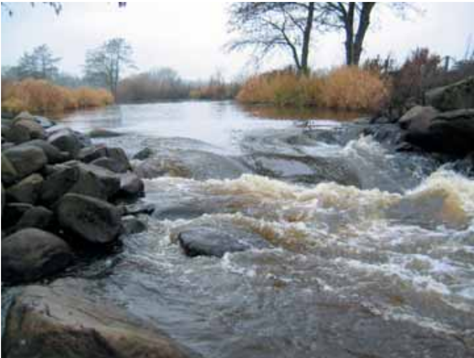
Foto 12: Eine geschüttete Gleite mit rückgestautem Abschnitt oberhalb und erheblicher Einengung des Gewässerbetts durch eine massive Befestigung der Ufer und extremen hydrodynamischen Bedingungen.
