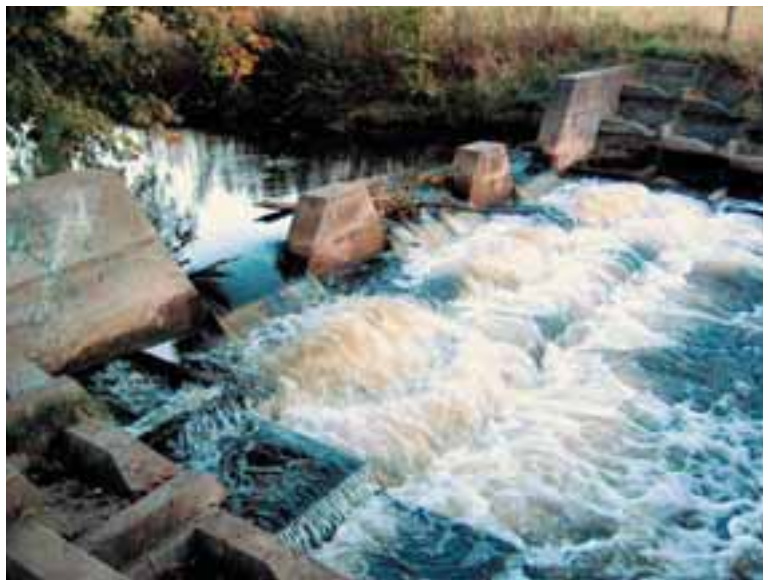
Foto 3a: Querbauwerke unterbrechen die longitudinale Durchgängigkeit der Gewässer für viele Fischarten und wirbellose Tierarten aufgrund starker Turbulenzen und Wasserspiegeldifferenzen sowie einer Unterbrechung der Sedimentschicht.
