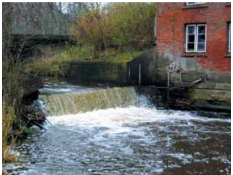
Foto 3c: Verschiedene Arten von Querbauwerken sind auch in kleineren Fließgewässern angelegt und unterbrechen die longitudinale Durchgängigkeit.
