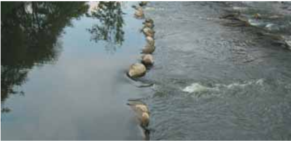
Foto 11: Ausschnitt aus einer Sohlgleite in Riegelbauweise, bei der kein Übergang zwischen dem rückgestauten Bereich oberstrom (mit Stillwasserbedingungen) und dem obersten, durchgehenden Querriegel besteht. Bei diesem Beispiel musste allerdings die Aufstauung aufgrund der örtlichen Rahmenbedingungen gehalten werden.
