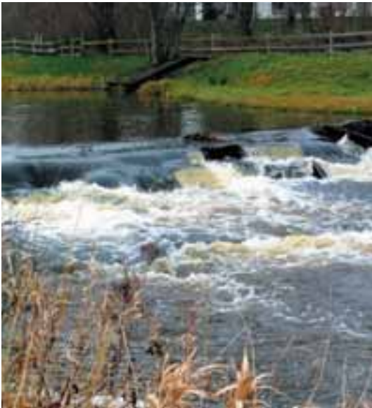
Foto 3a: Querbauwerke unterbrechen die longitudinale Durchgängigkeit der Gewässer für viele Fischarten und wirbellose Tierarten aufgrund starker Turbulenzen und Wasserspiegeldifferenzen sowie einer Unterbrechung der Sedimentschicht.
