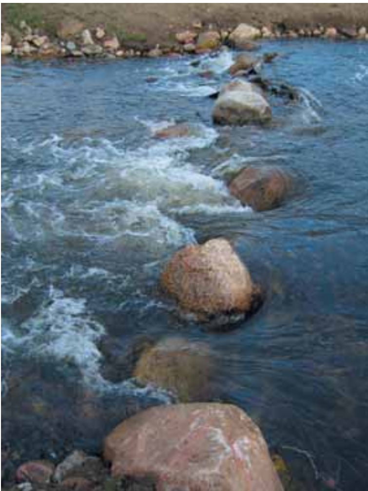
Foto 9: Durchgehender Riegel mit hoher Fließgeschwindigkeit ober- und unterstrom im gesamten Querschnitt, d.h. es fehlen strömungsberuhigte Bereiche, die auch zur Passage von weniger schwimmstarken Fischen genutzt werden können.
