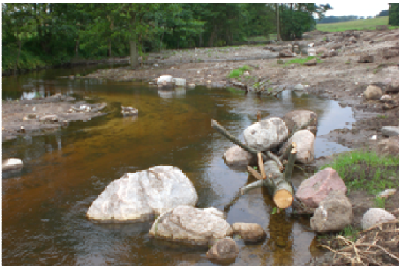
Beispiel zur Einbringung von Störsteinen und befestigten Baumstämmen
