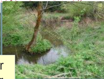
Rückbau von Staubauwerken
