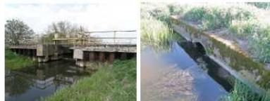
*Wehr 14a im Mittellauf der Randow ohne Möglichkeit für Fische auf- bzw. abzuwandern (li); zu klein dimensionierter Durchlass (im Unterlauf Gramzower Mühlbach)*
