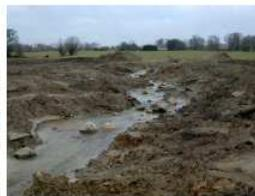
*Beispiel zur Anhebung der Sohle durch Abflachung der Uferbereiche*
