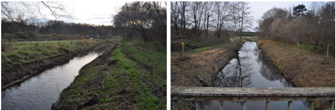
Abbildung 45: Abflussmessstelle Nr. 6 (links) und Nr. 7 (rechts)
