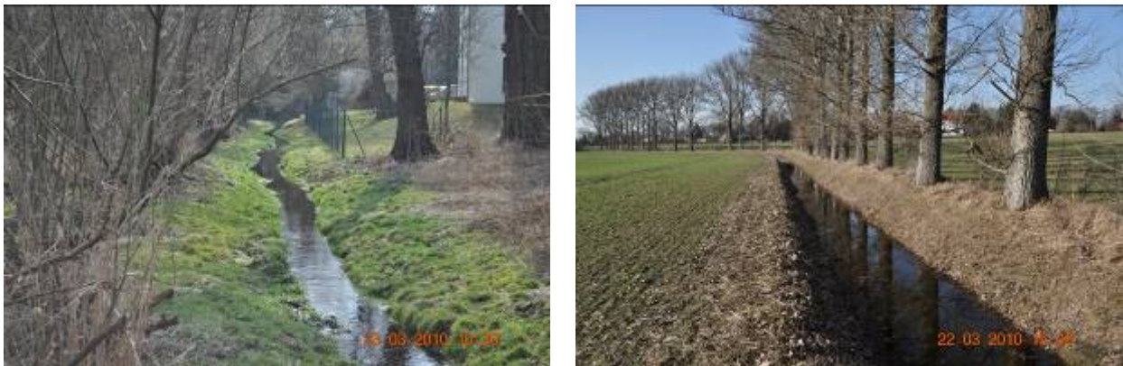
Abbildung 27: Hoher Graben Werneuchen bei Kilometer 0,4 (linkes Bild, in Fließrichtung) und bei Kilometer 2,35 (rechtes Bild, gegen Fließrichtung).
