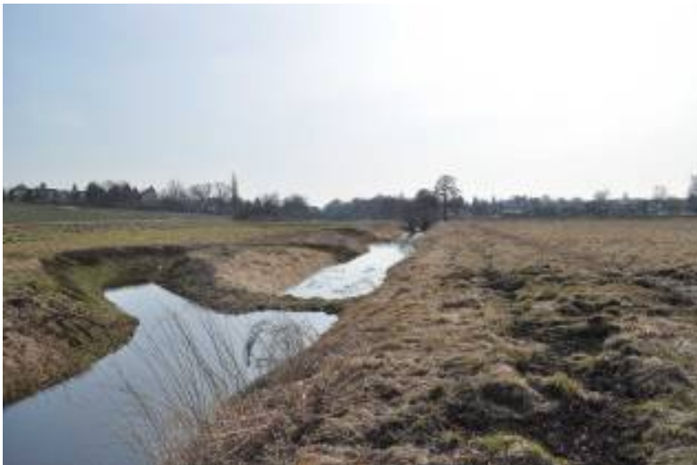
Abbildung 19: Sanierungsmaßnahme des Wasser- und Bodenverbandes
