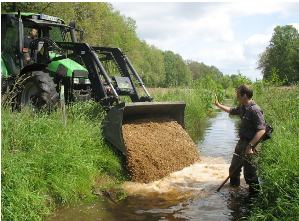
Kieseinbau im Lünzener Bruchbach
