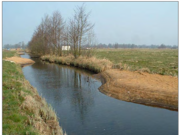
Abbildung 7.18: Einbau von Kiesbuhnen
