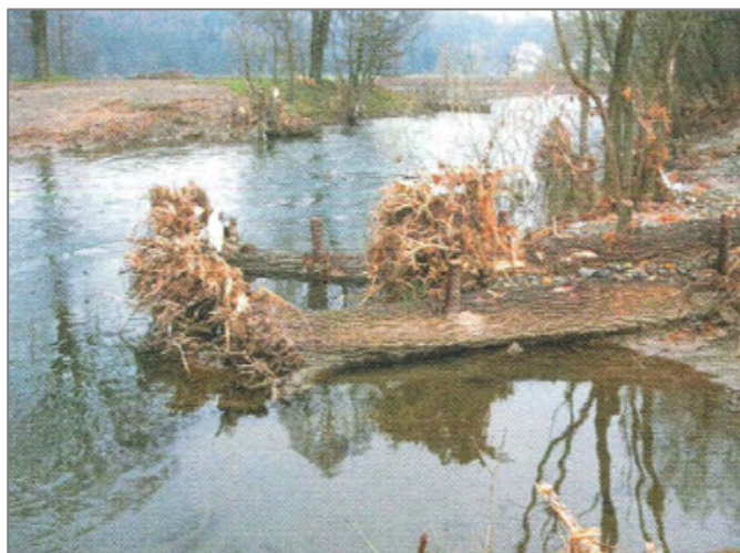
Abbildung 7.19: Einbau Totholz (Quelle: [30])
