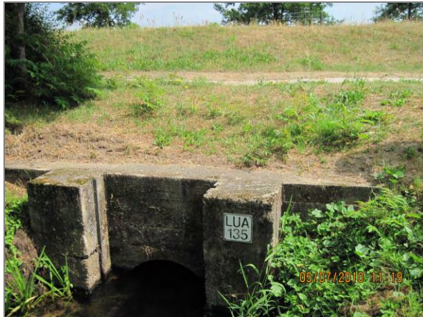
Abbildung 7.25: Abschlagsbauwerk vom Nordumfluter in das Nordfließ (Mittellauf)
