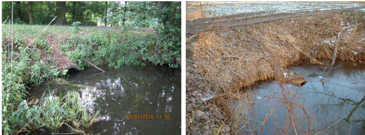
Abbildung 7.16 Durchlassbauwerk im Nordfließ (km 4+472 (9+972)) und Mühlengraben
