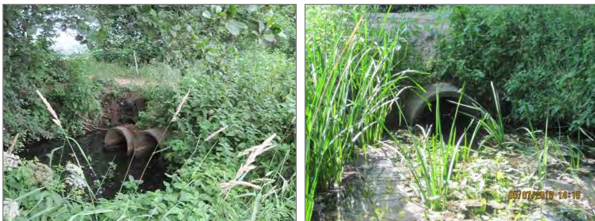
Abbildung 7.15 Durchlassbauwerke im Nordfließ (km 0+792, 1+875 (6+292, 7+375))
