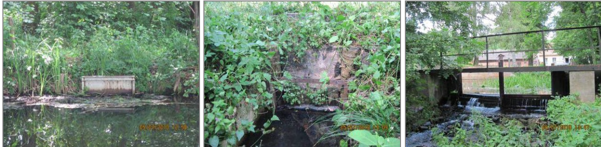
Abbildung 7.26 Abschlagsbauwerke im Nordfließ (Mittellauf) – Reihenfolge (li-re) nach Tabelle 7.5
