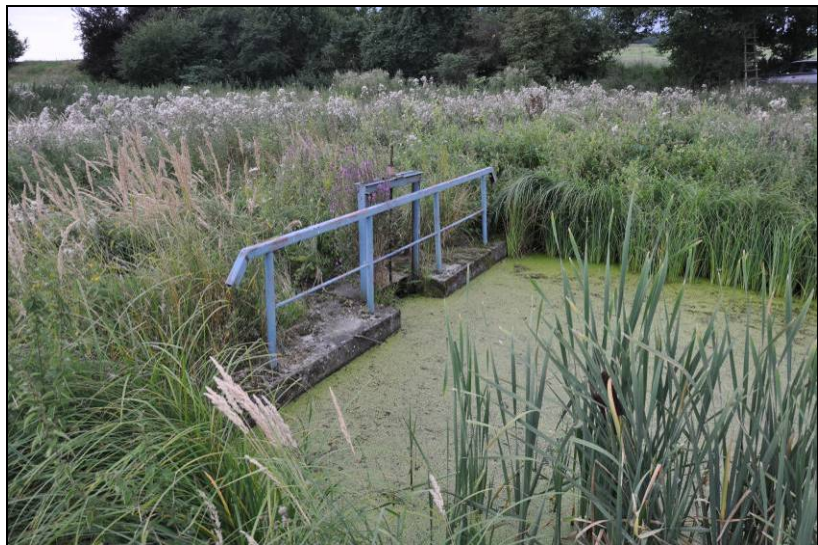
Abbildung 60: Genutzter Stau zur Wasserregulierung im Rahmen landwirtschaftlicher Nutzung unterhalb der „Quelle“ des künstlichen Oberlaufs des Schurkengrabens (Foto: F. Tugendheim, 12.08.2010)
