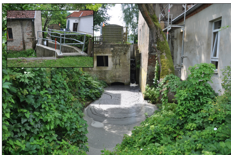
Abbildung 64: Sehr hoher Absturz am Mühlenstau Alt Rosenthal von Oberstrom (Links oben) und Unterstrom. (Beide Fotos: F. Tugendheim, 12.08.2010)
