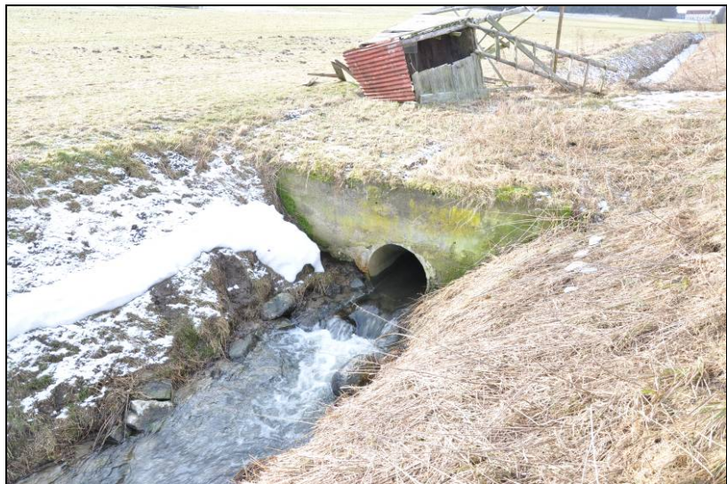
Abbildung 32: Abschnitt der Lechnitz mit Rohrdurchlass und eingetieftem Profil bei Stat. km 01+600 (Foto: F. Tugendheim, 03.03.2010)
