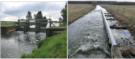
Löcknitz - Wehr Breetz (li), Fischaufstiegsanlage am Wehr Mesekow (re)
