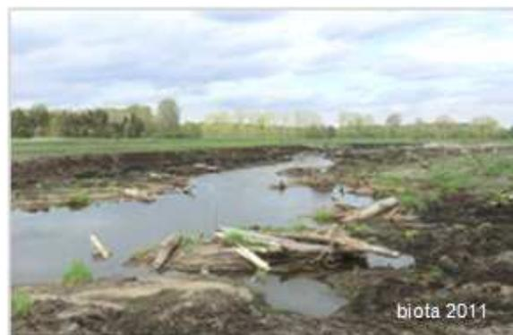
Abbildung 19: Einbau von Totholz
