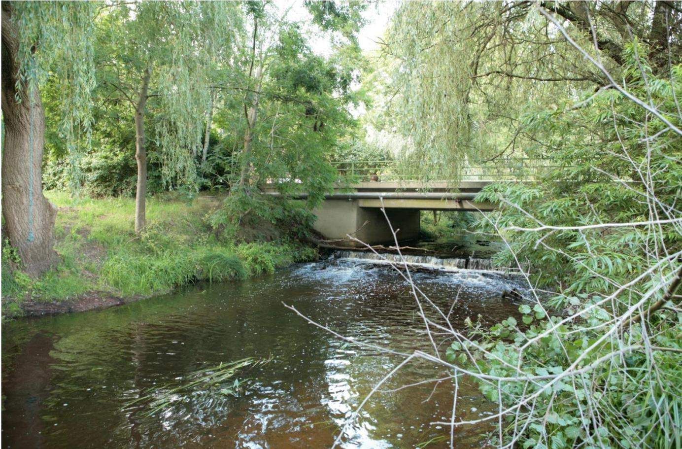
**Standort 13:** 9+732 stromaufwärts (04.09.10) Brücke Clüversborstel, Sohlabsturz in Form von Spundwand ca. 60cm, möglicher Einbau einer Sohlgleite um die ökologische Durchgängigkeit wieder herzustellen
