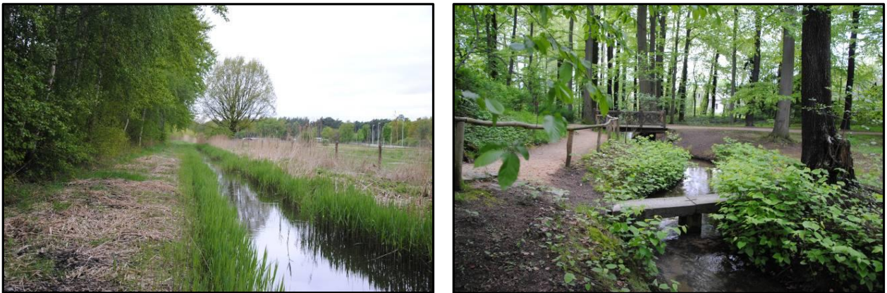
Abbildung 67: Branitzer Hauptgraben bei km 1+400 (li.) und km 3+800 (re.)
