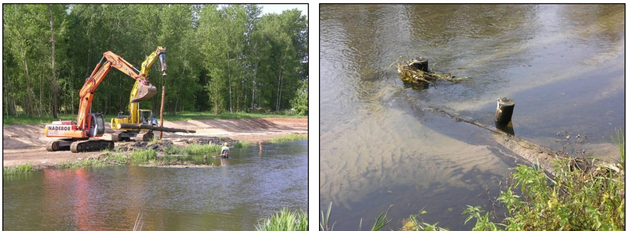
Abbildung 72: Raubaubuhne als Strukturierungselement im Rahmen der Renaturierung der Spreeaue (VEM) im Bau (links), Bildung von Verlandungszone und Kolk (rechts)
