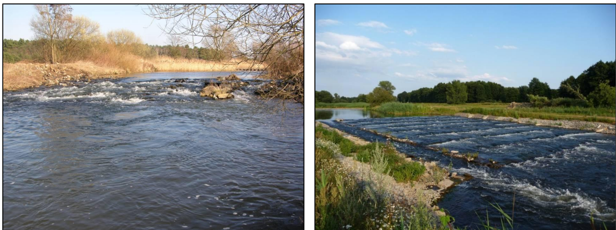
Abbildung 71: Umbau einer Sohlrampe zu einer Sohlengleite in Beckenbauweise mit kombinierter Kanugasse, Sohlrampe vorher (links) und nach dem Umbau (rechts)
