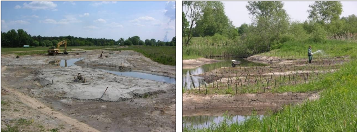
Abbildung 73: Initiierung einer Sekundäraue mittels Vorlandabsenkung sowie Bepflanzung, Vorlandabsenkung im Bau (links) und Pflegemaßnahmen (rechts)
