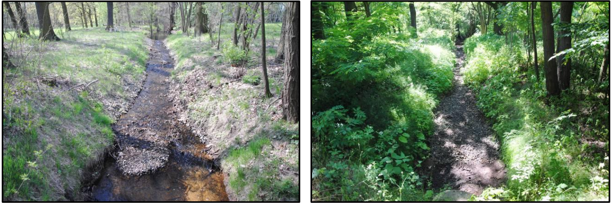
Abbildung 66: Koppatzer Landgraben, Stützwelle bei km 3+000 am 28.04. (li.) und trocken am 28.06.2010 (re.)
