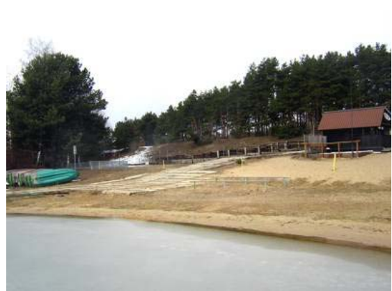
Abbildung 12: Objekttyp 3.2.2 – Strandbadanlage inkl. Infrastruktureinrichtungen (hier: Bootslager, Slip, Versorgungsgebäude) am Nordufer des Helensees
