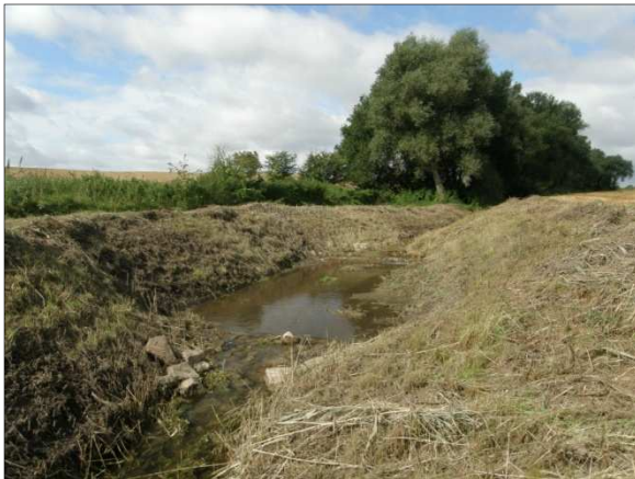
Abbildung 5-27: Sohlrampe in P01 am Eickstedtgraben (DE69628824_1662)
