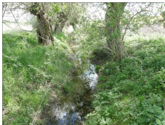
Abbildung 5-24: Sohlrampe in P01 am Mühlenbach Grünz (DE6962882_1522)
