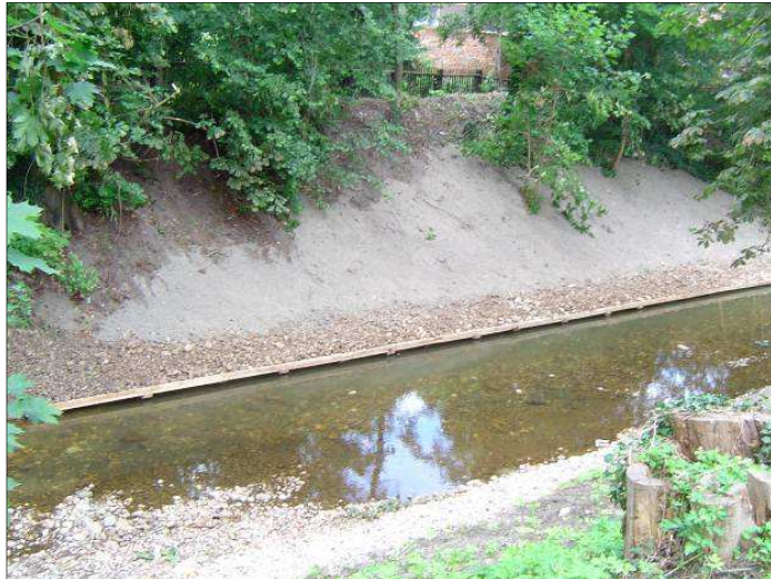
Abbildung 7-18: Hedingkehlbuhnen im Bauzustand an einem Beispielgewässer (ELLMANN o. J.)
