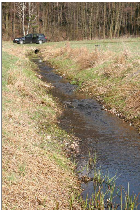
Abbildung 7-27: Sohlsicherung an einer geöffneten Verrohrung in Form einer Rausche-Kolk-Gestaltung aus Kiessubstrat an einem Beispielgewässer (ELLMANN 2006)
