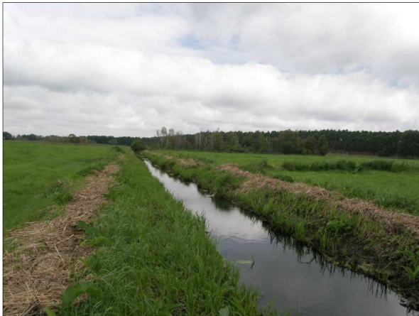
Abbildung 5-41: Geradlinigkeit, Böschungsmahd und Grünlandflächen im Umland in P01 am Torfgraben Blumberg (69628892_1665)
