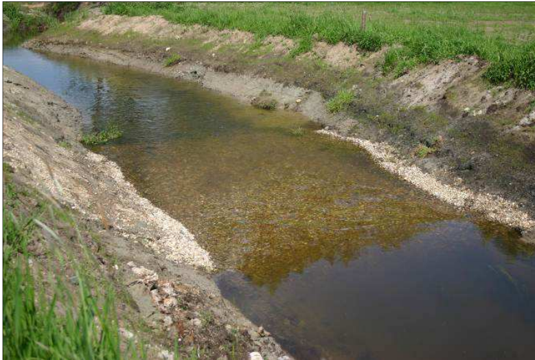
Abbildung 7-25: Kiesriffle (Bauzustand) an einem Beispielgewässer (ELLMANN 2004)
