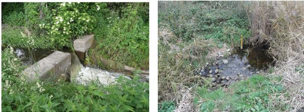
Abb.: links: vorhandener Stau, rechts: errichtete Sohlschwelle
