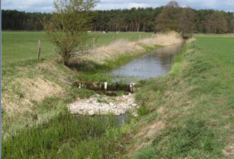
Stützschwelle km 5,8: BW 21
