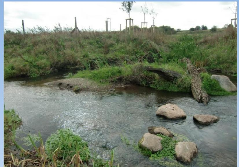
Beispiele zur Habitatverbesserung und Vitalisierung: Einbau Steine, befestigte Baumstämme, eingebrachte Wurzelstubben
