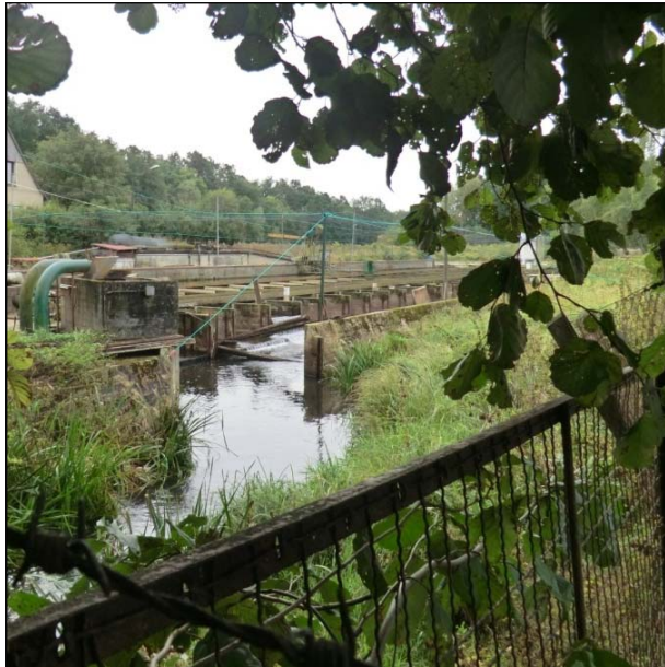
Abbildung 2-36: Betonrinnenanlage Fischaufzucht „Obere Plane“ an der Plane
