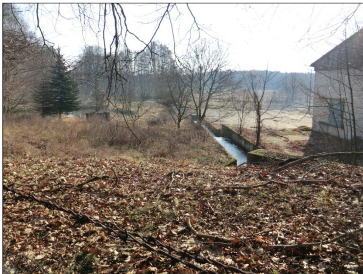
Abbildung 2-37: Verlauf der Buckau mittels Betonsohlenrinne auf dem Gelände Fischaufzucht Herrenmühle
