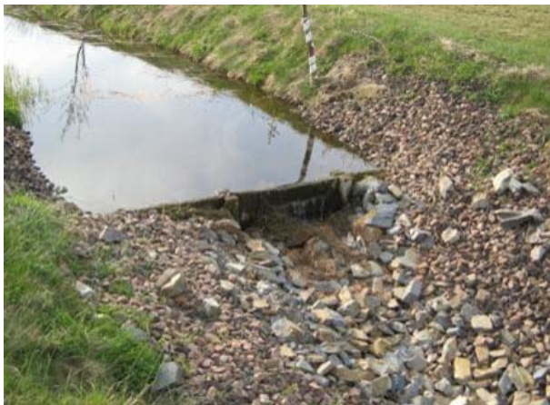
Abbildung 47: Stützschwelle im Bereich der Hochfläche (P06)
