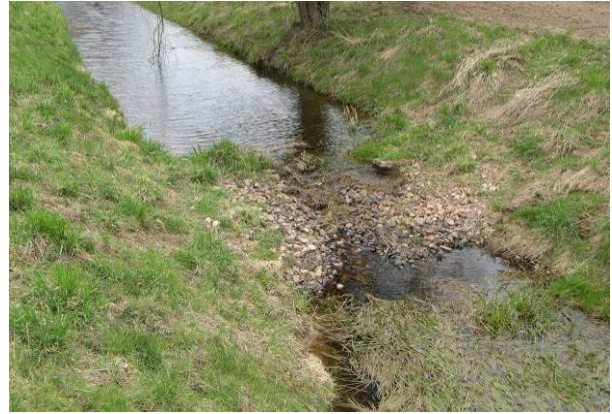
Abbildung 42: Stützschwelle in P01
