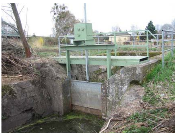
Abbildung 65: Stau Düker Ruppiner Kanal (P06)
