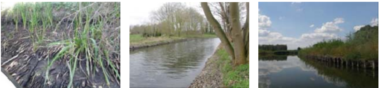
Abbildung 79: Ufer- und Böschungssicherungen im Abschnitt P03, P12 und P15
