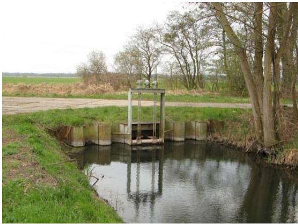
Abbildung 45: Stau vor Einmündung in den Königsgraben (P01)
