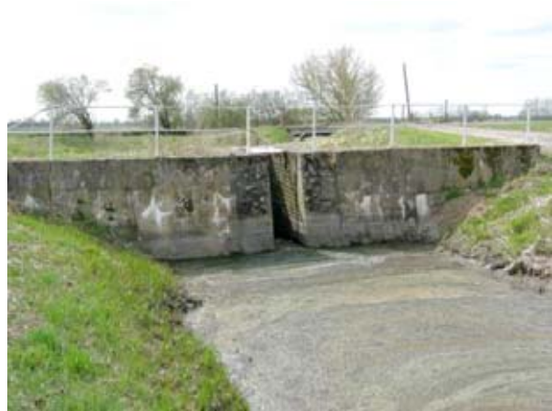
Abbildung 104: Düker unter dem Königsgraben
