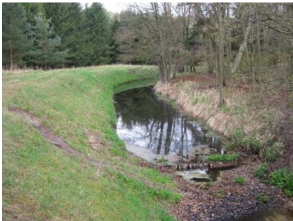
Abbildung 53: Stützschwelle Wald (P04)
