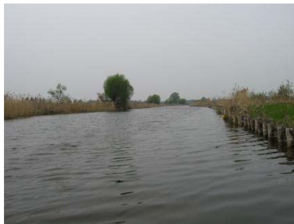
Abbildung 72: Kanal mit erneuerten Ufersicherungen (P04)
