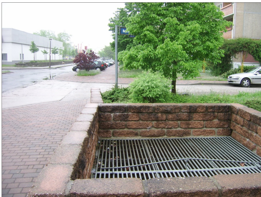
Abbildung 5-2: Luftschacht der verdolten Schacke im Stadtgebiet von Finsterwalde
