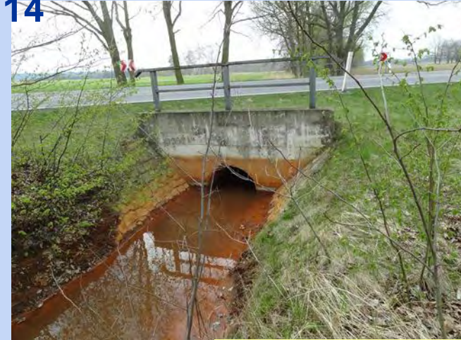
Kohlegraben bei km 10+780
