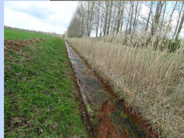
Goßmar- Luckauer- Grenzgraben: km 6+700, Eisenbelastung, Algen
