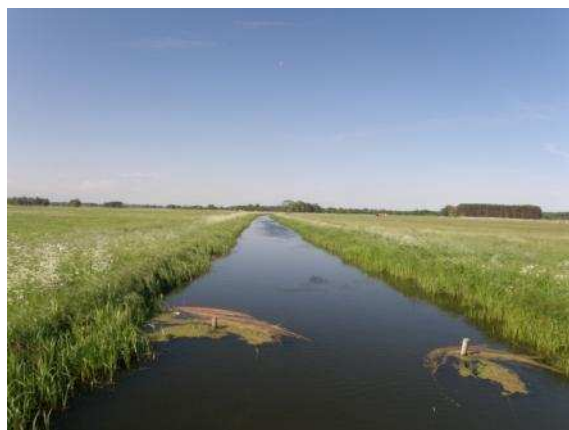
Abbildung 5-43: Brück-Neuendorfer Kanal, oberhalb des Wehres Schäpe
