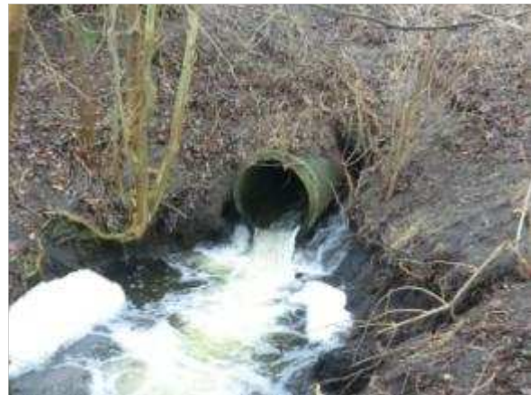
Abbildung 5-9: Links Rohrdurchlass ohne Substrat auf der Sohle, rechts unüberwindbarer Sohlprung Brücken besitzen in Bezug auf die ökologische Durchgängigkeit für die Lebewesen im Wasser überwiegend keinen restriktiven Faktor. Sie erhielten als Bauwerksgruppe eine separate Beurteilung in Bezug auf die Wandermöglichkeit der FFH-Art Fischotter. Die Thematik ist nicht explizit WRRL-relevant, aber bedeutungsvoll im Zusammenhang mit der FFH-Richtlinie. Die Tiere, die aufs Wasser angewiesen sind, steigen auf der Suche nach neuen geeigneten Lebensräumen oder zur Partnersuche aus dem Gewässer aus und wandern entlang der Ufer weiter. Die für den Fischotter zu querenden Bauwerke an den Gewässern (Brücken, Röhrendurchlässe oder Wehranlagen in der Nähe von Straßen) sind häufig ohne Böschungen bzw. Bermen angelegt, so dass er den Weg über die Straße wählt, was häufig an hoch frequentierten Straßen ein Todesurteil bedeutet ( REUTHER 2002, MUGV 1999, MIR 2008 ).
