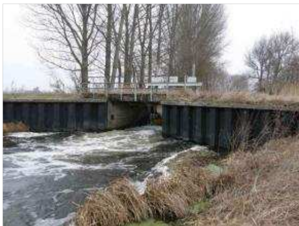
Abbildung 2-22: Wehr Nackel (Temnitz)
