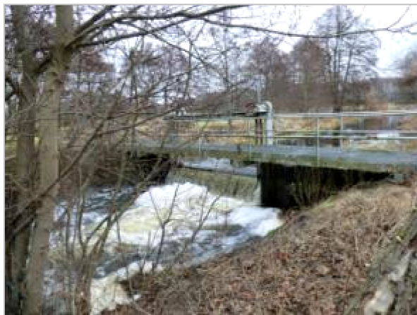
Abbildung 5-12: Wehr Paalzow in der Temnitz (5886_197)
