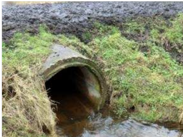
Abbildung 5-9: Links Rohrdurchlass ohne Substrat auf der Sohle, rechts unüberwindbarer Sohlprung Brücken besitzen in Bezug auf die ökologische Durchgängigkeit für die Lebewesen im Wasser überwiegend keinen restriktiven Faktor. Sie erhielten als Bauwerksgruppe eine separate Beurteilung in Bezug auf die Wandermöglichkeit der FFH-Art Fischotter. Die Thematik ist nicht explizit WRRL-relevant, aber bedeutungsvoll im Zusammenhang mit der FFH-Richtlinie. Die Tiere, die aufs Wasser angewiesen sind, steigen auf der Suche nach neuen geeigneten Lebensräumen oder zur Partnersuche aus dem Gewässer aus und wandern entlang der Ufer weiter. Die für den Fischotter zu querenden Bauwerke an den Gewässern (Brücken, Röhrendurchlässe oder Wehranlagen in der Nähe von Straßen) sind häufig ohne Böschungen bzw. Bermen angelegt, so dass er den Weg über die Straße wählt, was häufig an hoch frequentierten Straßen ein Todesurteil bedeutet ( REUTHER 2002, MUGV 1999, MIR 2008 ).
