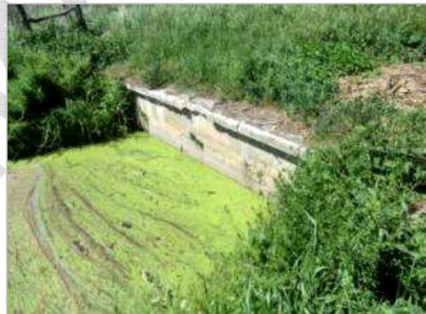
Abbildung 5-44: überstauter Plattendurchlass im Rhingraben
