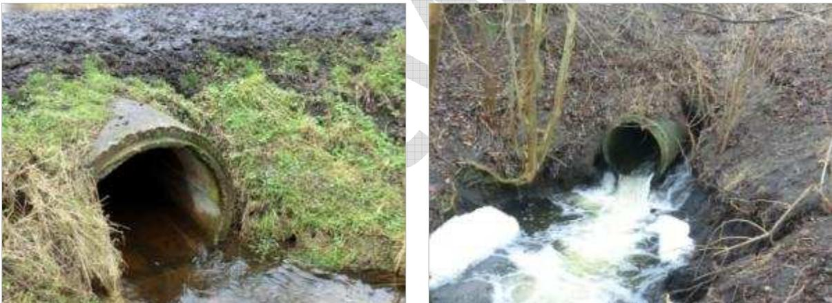
Abbildung 5-40: Links Rohrdurchlass ohne Substrat auf der Sohle, rechts unüberwindbarer Sohlprung
