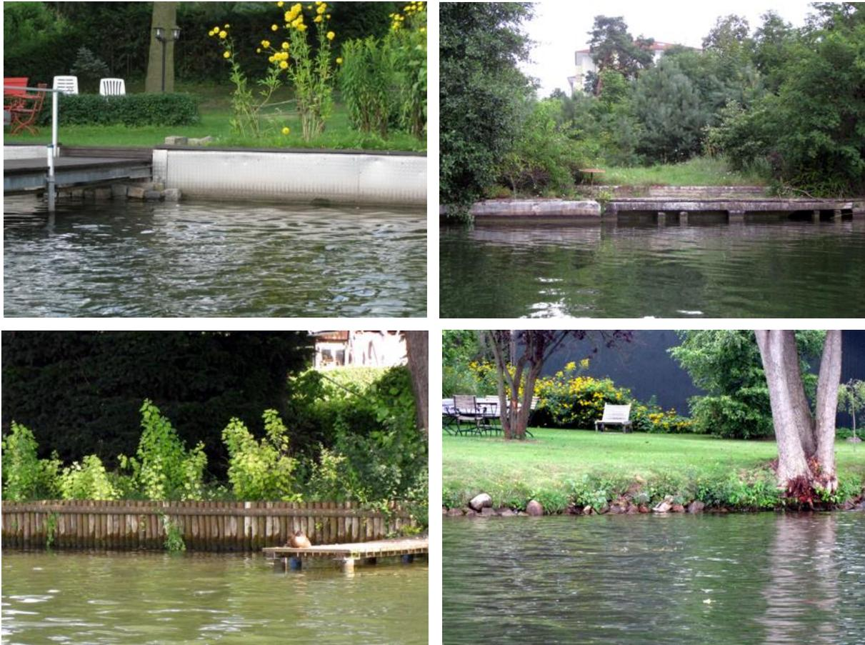
Abbildung 51: Formen des Uferverbaus an den Seen des GEK-Bearbeitungsgebietes: links oben - Aluminium-Bleche am Peetzsee (Südostufer, 10.08.2012); rechts oben - massive, etwa 1,2 m hohe Betonverbauung zum Schutz einer Vorschüttung am Werlsee (Nordufer, 06.08.2012); links unten - massive Palisaden-Wand am Peetzsee (Nordostufer, 07.08.2013); rechts unten - Befestigung aus Geröllen und Blöcken, mit Stauden und Gehölzen überwachsen am Peetzsee (Westufer, 07.08.2012).
