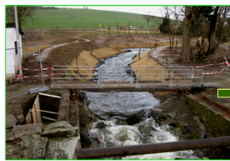
Flurbereinigung Wulften; Anlage eines durchgängig gestaltetem Wehr zwischen Hackenbach und ehemals gedükertem Mühlgraben (2006 und 2013)
