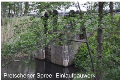
Pretschener Spree- Einlaufbauwerk
