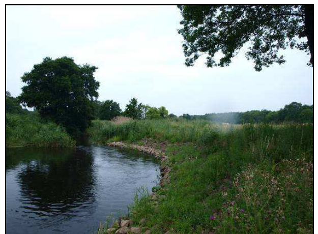
Abbildung 2-38: Ufersicherung der Kolkbildung an der Stepenitz (Abschnitt 11,2).
