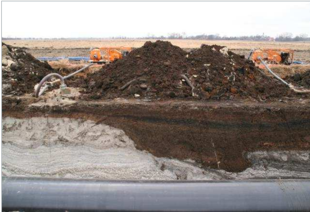
Welseniederung; Einsicht während des Baus der Opaltrasse (Foto: J. Zeitz)
