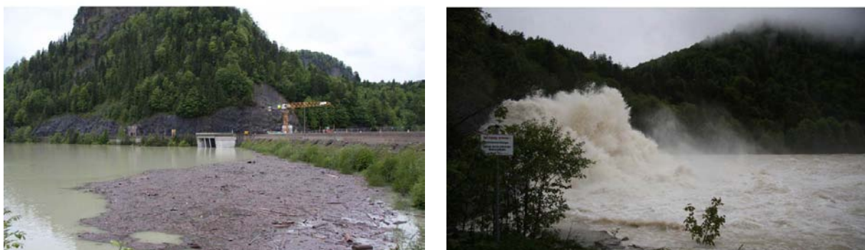
Abb. 3-6: Sylvensteinspeicher beim Hochwasser 2013, links: Hochwassereinstau am Damm; rechts: Hochwasserentlastung in Betrieb
