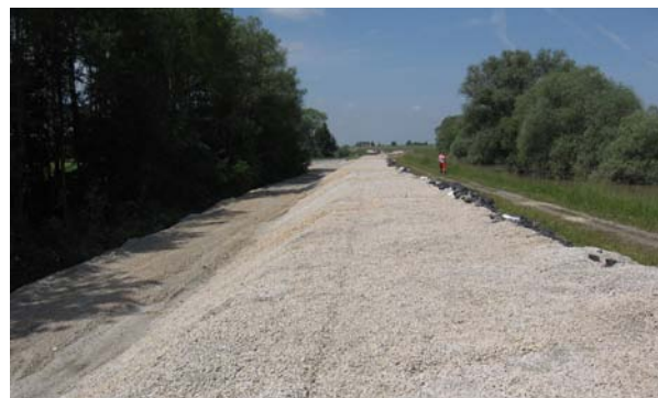
Abb. 4-3: Ruckasing, Gde. Osterhofen, Deichverteidigung durch Erhöhung der Deichkrone beziehungsweise Auflastschüttungen
