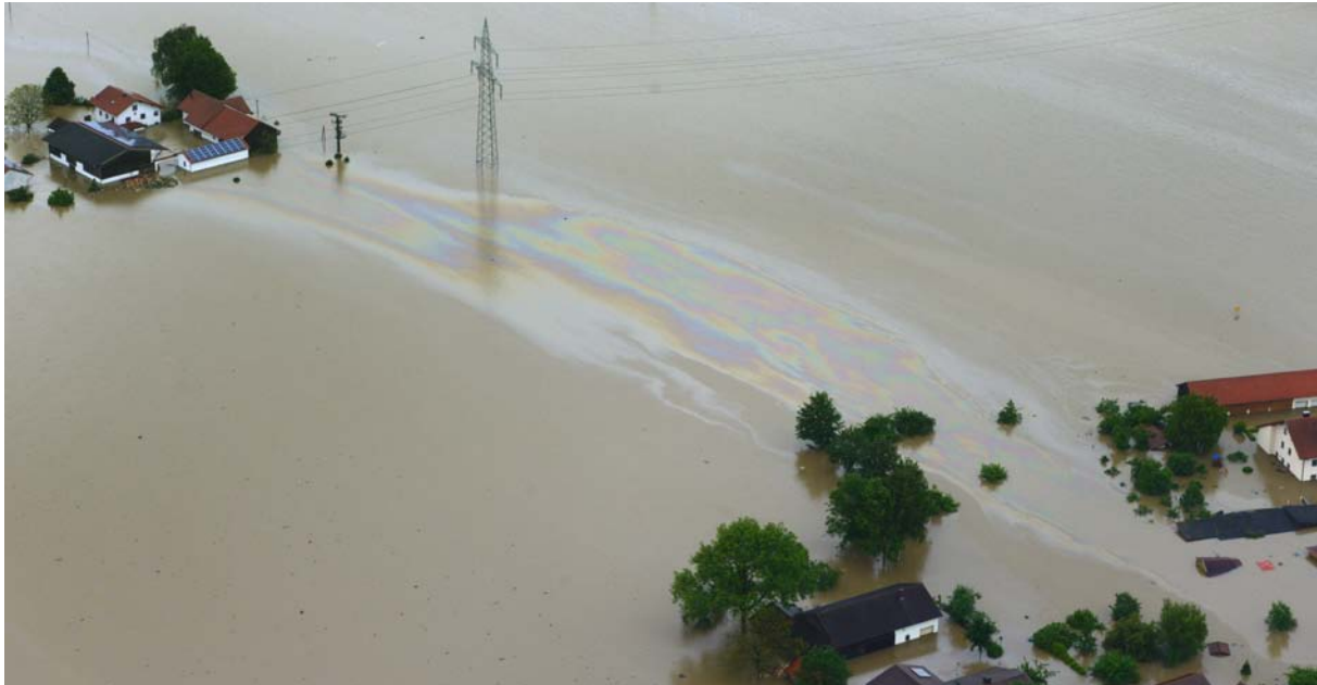
Abb. 7-1: Durch das Hochwasser verursachter Ölschaden
