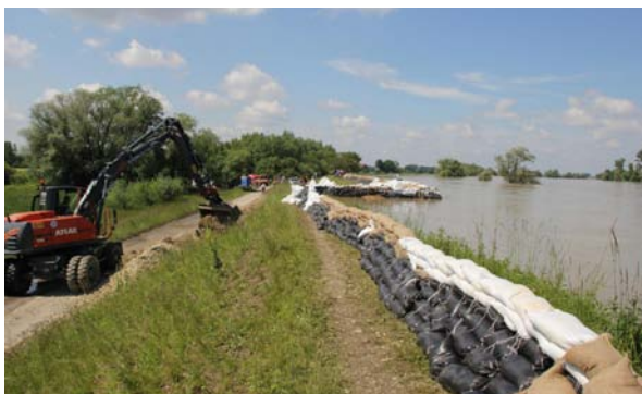
Abb. 4-3: Ruckasing, Gde. Osterhofen, Deichverteidigung durch Erhöhung der Deichkrone beziehungsweise Auflastschüttungen
