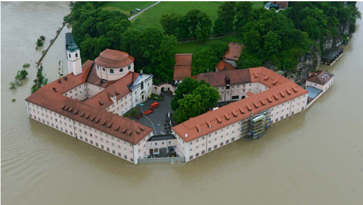
Abb. 4-1: Kloster Weltenburg an der Donau geschützt durch das mobile Hochwasserschutzsystem
