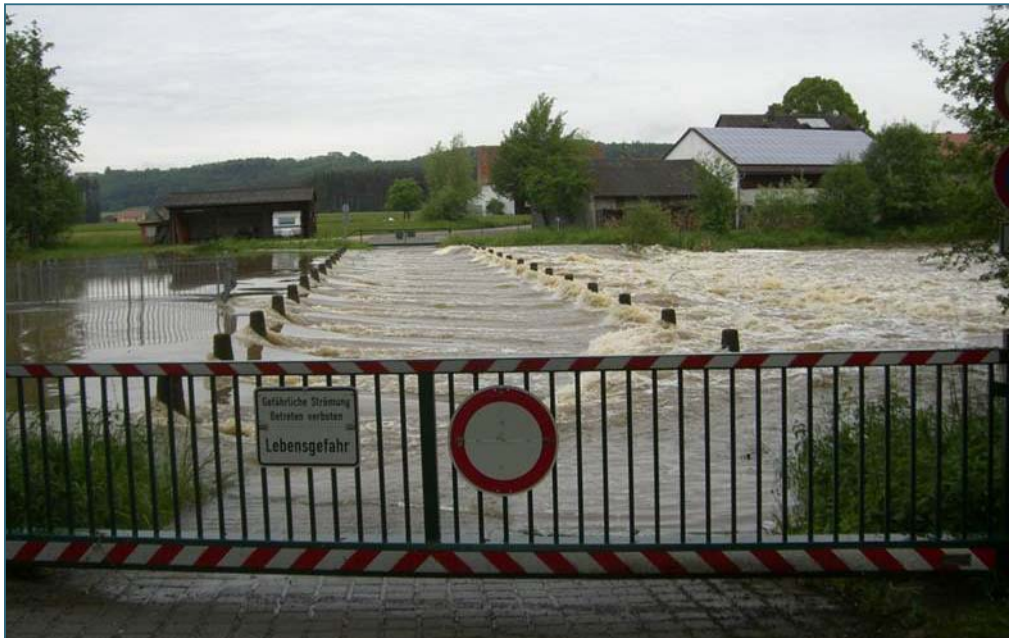
Abb. 3-2: Altmühlüberleitung am Hühnermühlendamm
