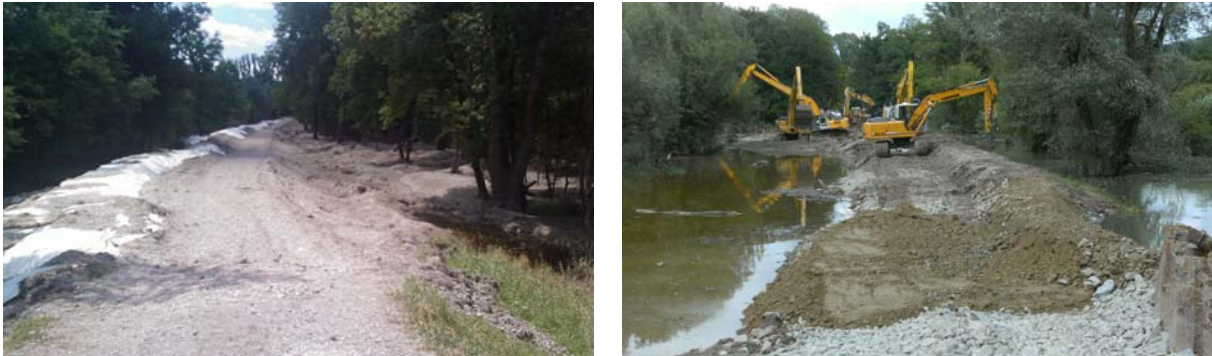
Abb. 4-4: Deichbruch Isar, Bau eines Notdeiches zum Schutz vor der zweiten Hochwasserwelle
