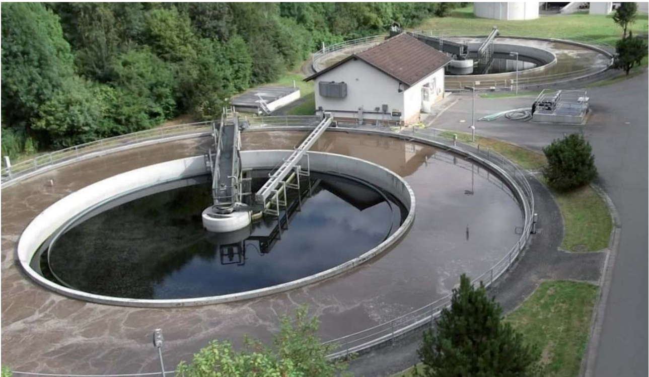
Umrüstung der Kläranlage Felsalbe, Stadt Pirmasens
