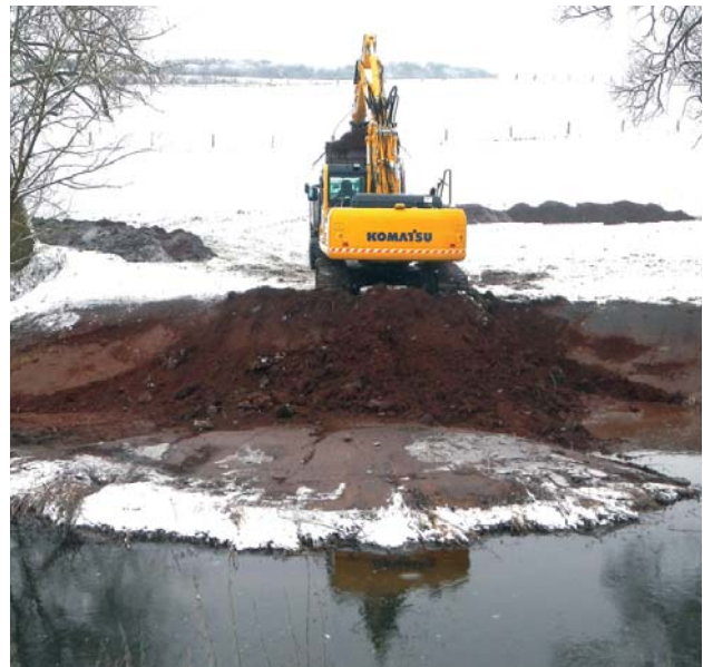
Umbaumaßnahmen an der Twiste
