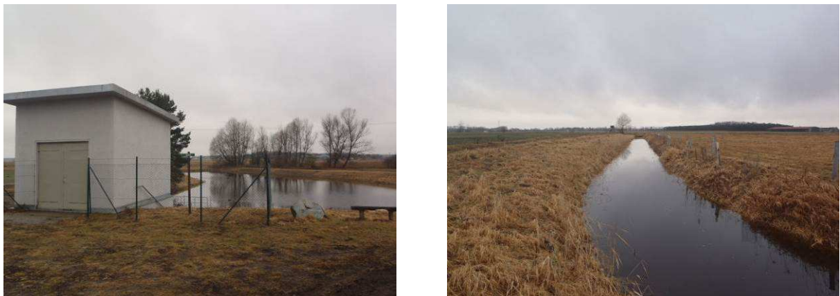
Abb. 51: Mittweider Torfgraben Fotos Planungsabschnitt MTG_P 04
