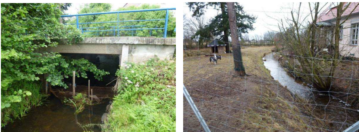
Abb. 29: Resser Mühlenfließ Fotos Planungsabschnitt RMF_P 13
