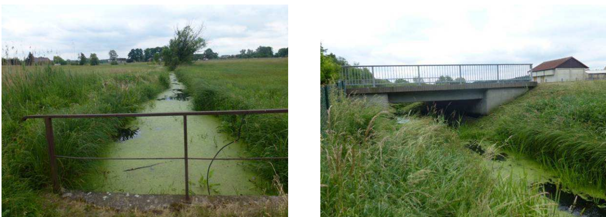
Abb. 33: Resser Mühlenfließ Fotos Planungsabschnitt RMF_P 15
