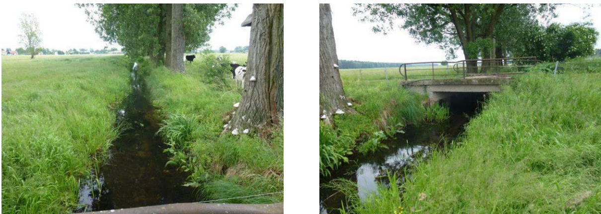
Abb. 31: Resser Mühlenfließ Fotos Planungsabschnitt RMF_P 14
