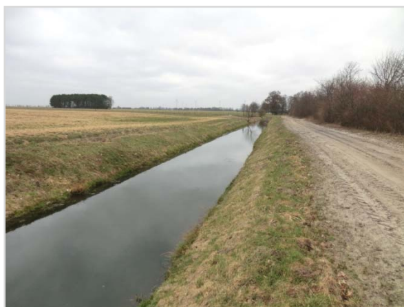
Abbildung 6: Göbengraben südlich von Zapel
