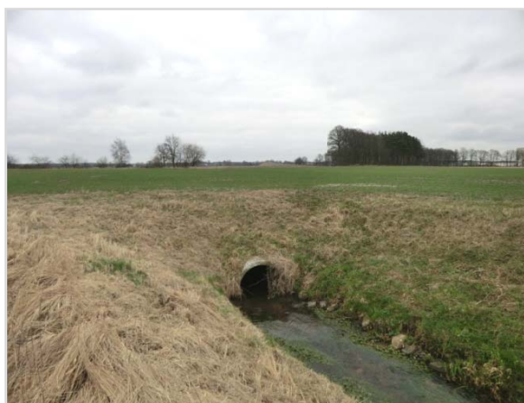
Abbildung 7: Verrohrung des Postliner Grabens
