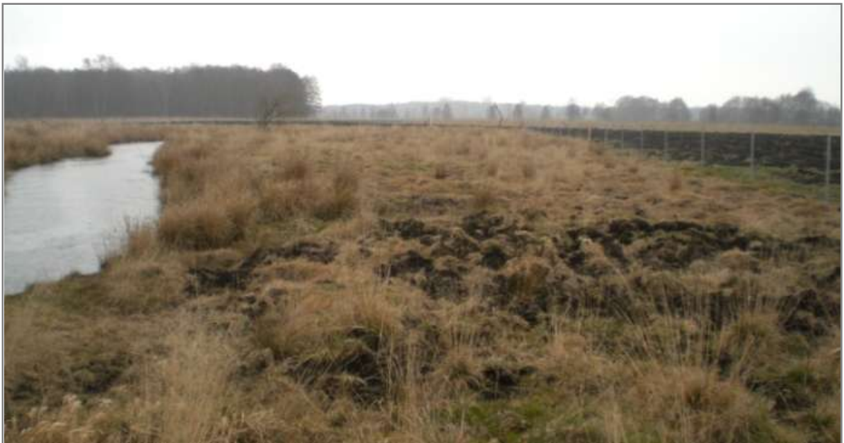
Abbildung 4-7: Beispiel für Unebenheiten einer Wasserwechselzone (Nebel bei Hoppenrade weniger als ein Jahr nach der Bauausführung)
