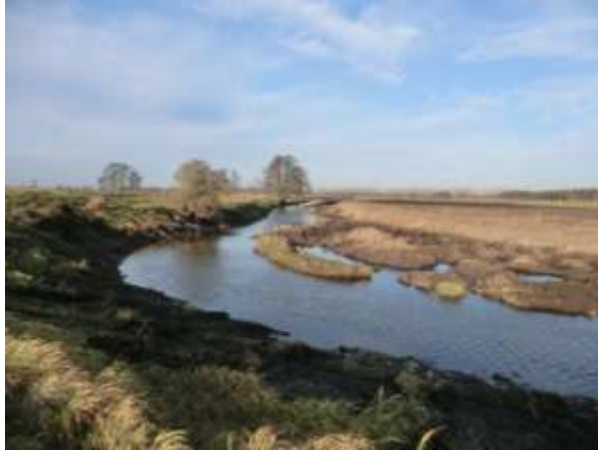
Abbildung 4-12 Laufverschwenkung der Alten Nebel bei Lüssow während der Bauausführung mit Ausbildung eines flachen Gleithangbereiches
