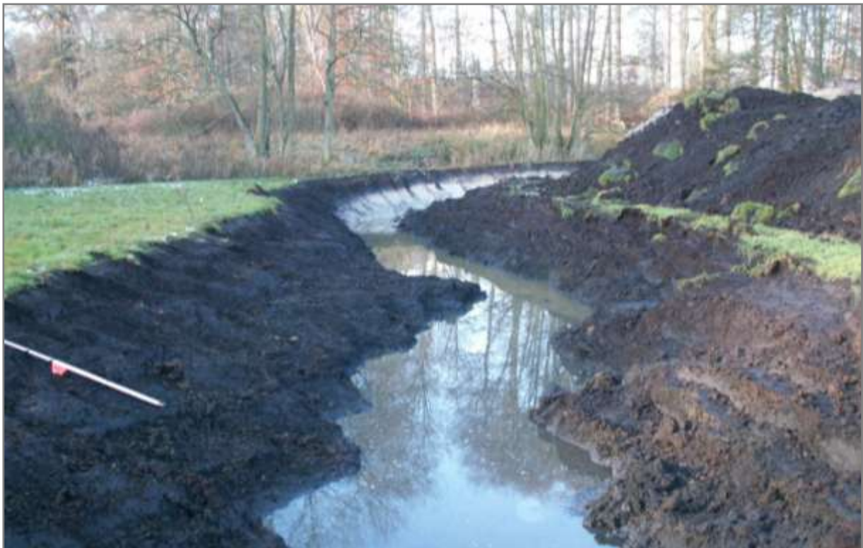
Abbildung 4-14: Beispiel für das Anlegen unregelmäßiger Uferböschungen
