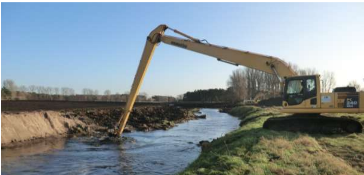
Abbildung 4-16: Einarbeiten von Baustämmen bei der Laufverschwenkung in der Alten Nebel
