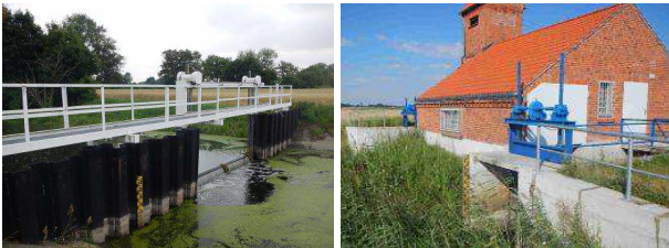
Wehr Bergerdamm - GHHK SW Witzke I—Großer Grenzgraben Witzke
