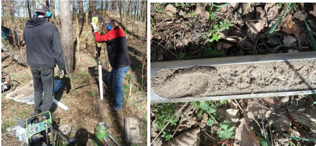
Abb. 13: Durchführung der Rammkernsondierungen im Gelände im März 2014 zur Errichtung der temporären Grundwassermessstellen (s. Kap. 4.2)
