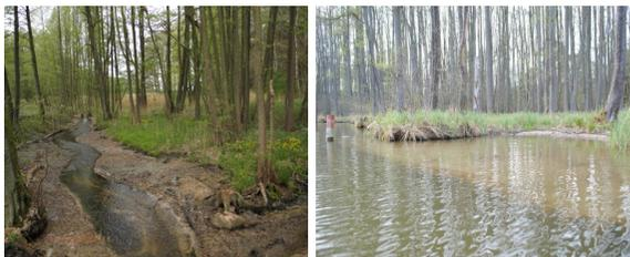
Naturnahe Sohlgleite (links) im Faulen Fließ bei Kappe kurz nach der Fertigstellung (2013, Neigung 1:160). Beginn einer natürlichen Uferzonierung an der Woblitz (rechts).
