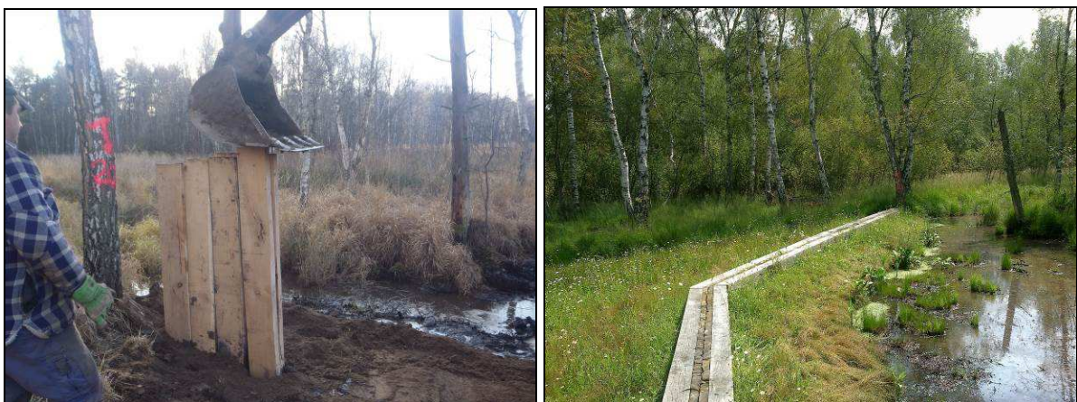
Abb. 49: Errichtung einer Stulpwand zur Abdichtung eines Moorgrabens im Naturpark Niederlausitzer Landrücken
