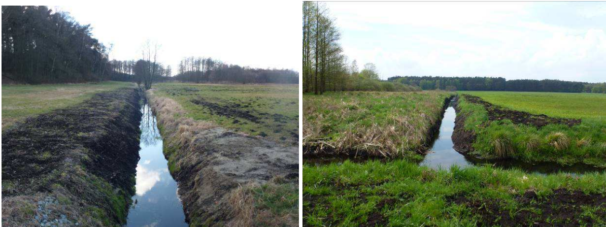
Abb. 16: Böschungsmahd (links) und Grundräumung (rechts) im Dammer Moor
