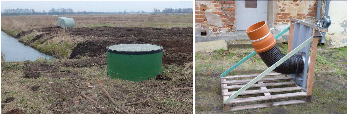
Abb. 45: Patentstau aus Kunststoff, geeignet insbesondere für Moorstandorte (links) und leichter Moorgrabenstau (rechts, Foto Hiekel 2015)
