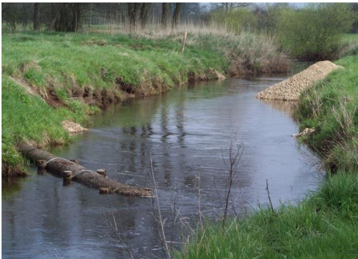
Abb. 10: Totholz- und Kiesdepoteinbau in der Jevenau (we_09)
