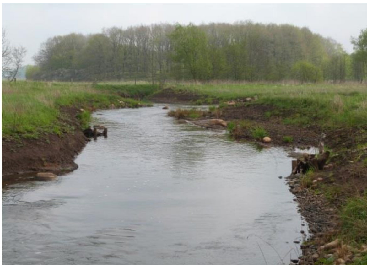
Abb. 11: Laufverlegung in der Hardebek Brokenlander Au (bk_02_a)
