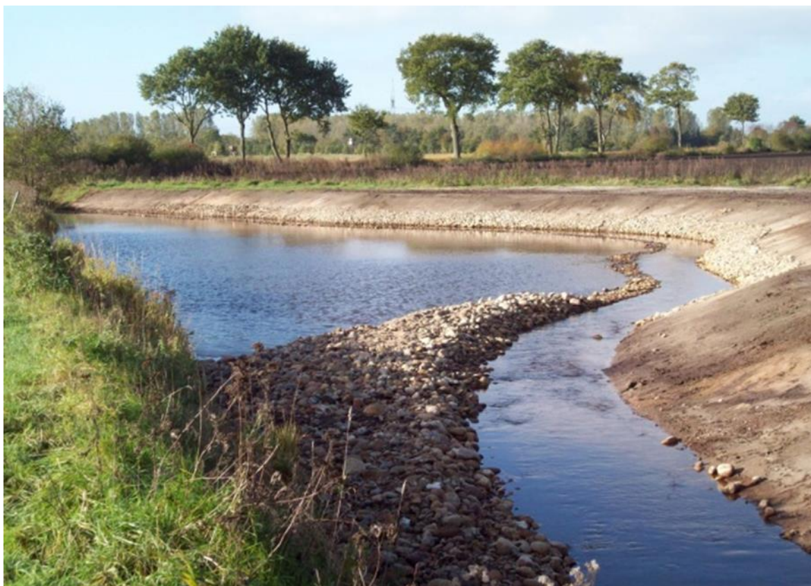
Abb. 15: Naturnaher Sandfang in der Bredenbek (ost_10_a)
