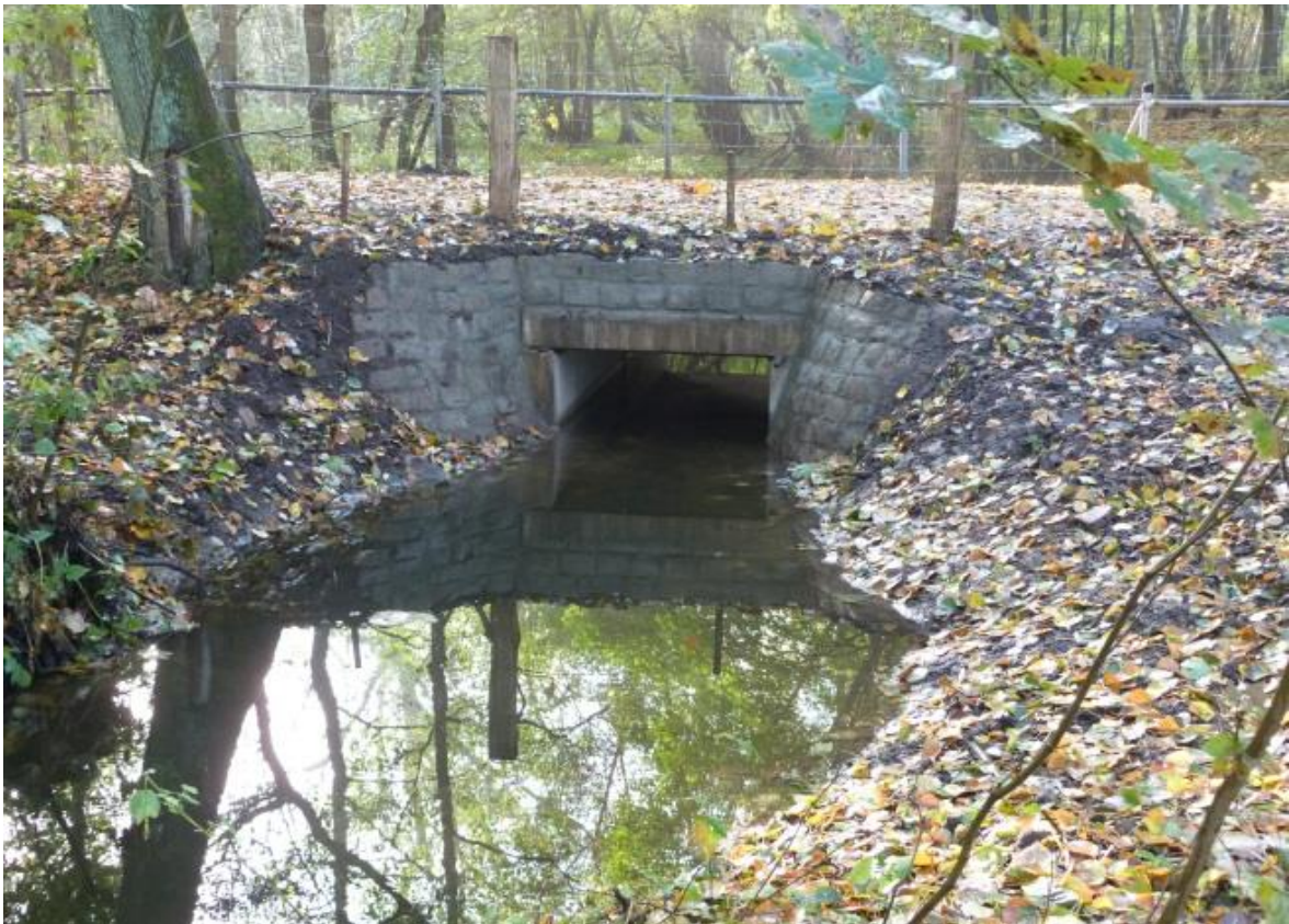
Abb. 17: Durchlass im Mühlenbach (al_11)
