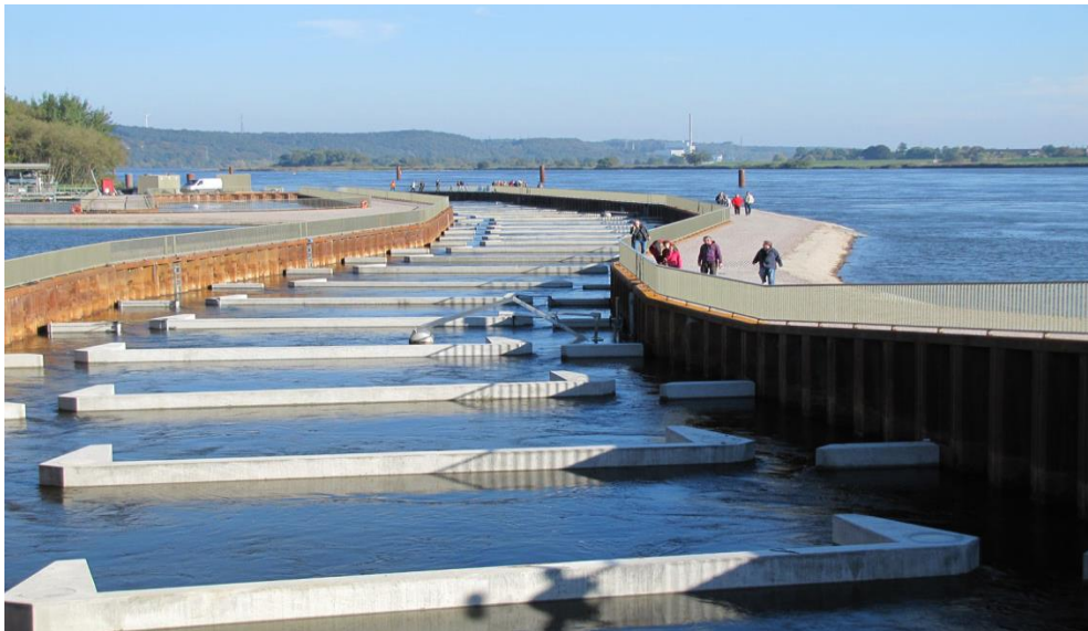
Abbildung 5.3: Wehr Geesthacht, Strom-km 586, Blick auf die Fischwechseleinrichtung am Nordufer (Quelle: Gaumert)
