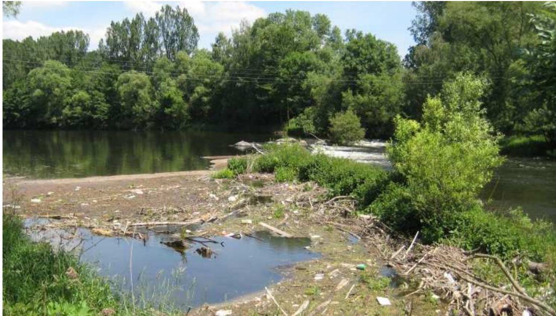
Abb. 14: Wehranlage Fischersdorf in der Saale vor Umgestaltung
