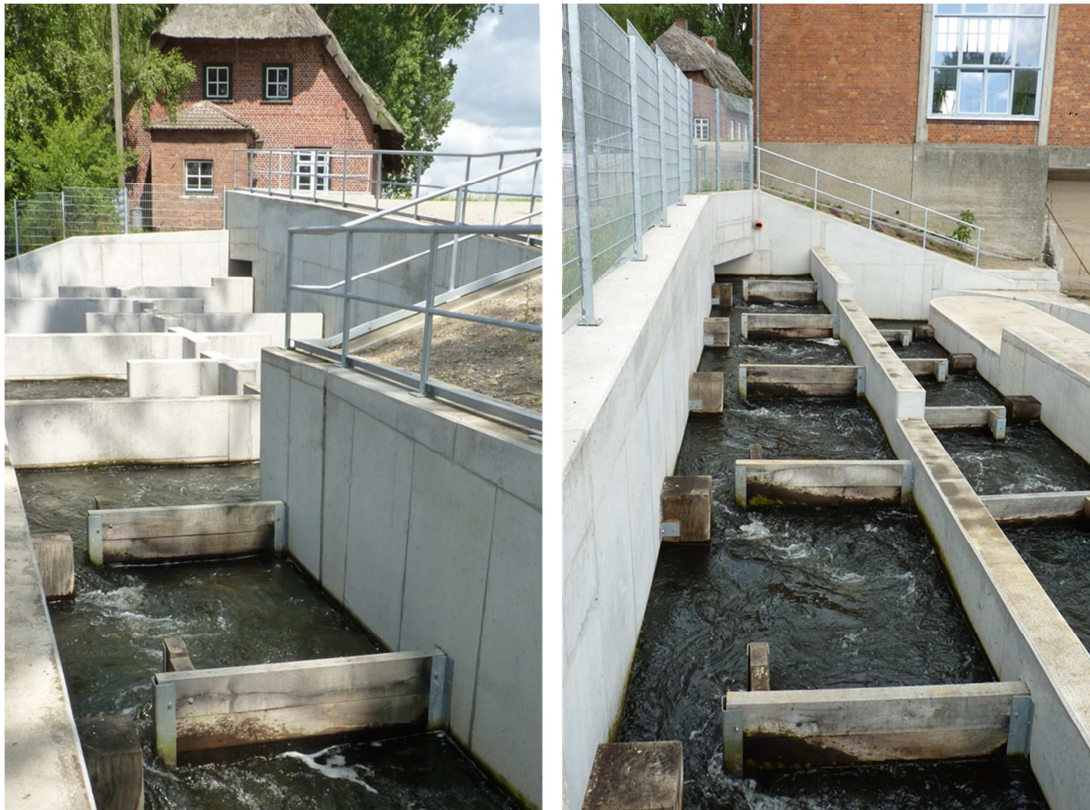
Abb. 16: Fischaufstiegsanlage Lewitz an der Müritz-Elde-Wasserstraße 2014
