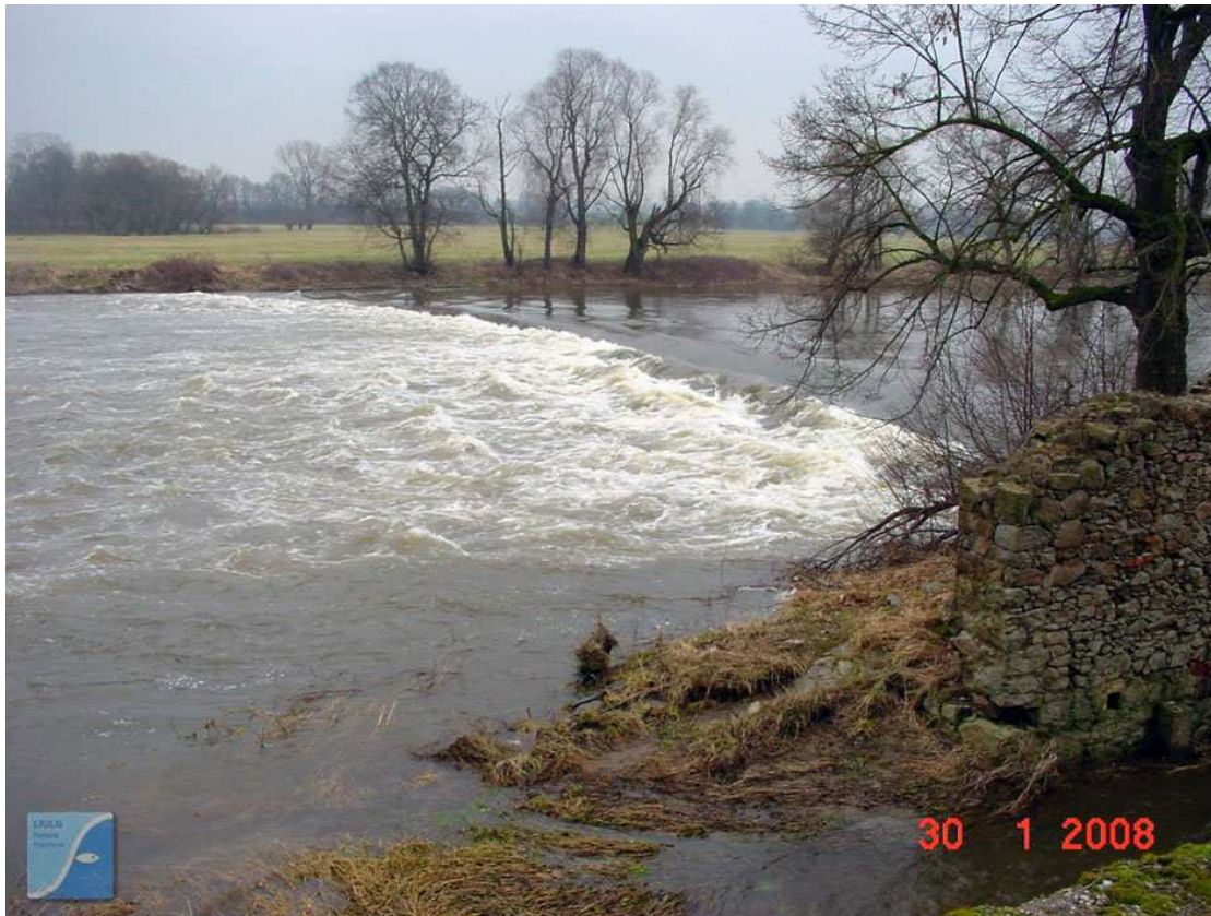
Abb. 9: Mulde Wehr Walzig – Seitenansicht altes Wehr 2008
