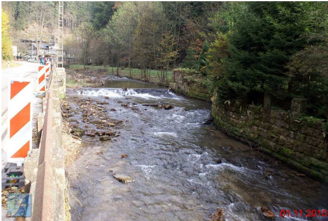
Abb. 7: Kirnitzsch Wehr Haidemühle – Ansicht altes Wehr 2010
