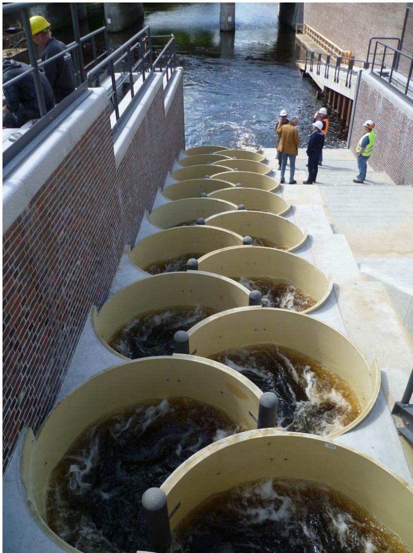
Abb. 3: Mäanderfischpass an der Fuhlsbüttler Schleuse
