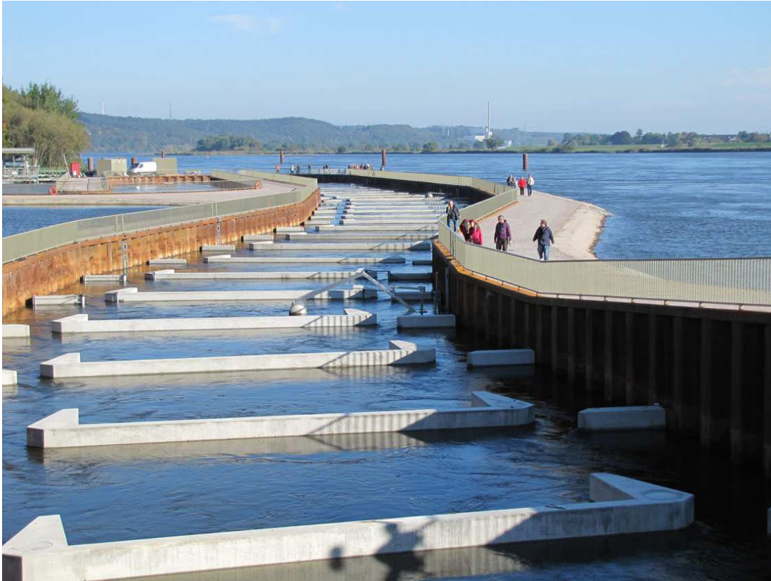
Abb. 17: Wehr Geesthacht, Strom-km 586, Blick auf die Fischwechseleinrichtung am Nordufer (Quelle: Gaumert)
