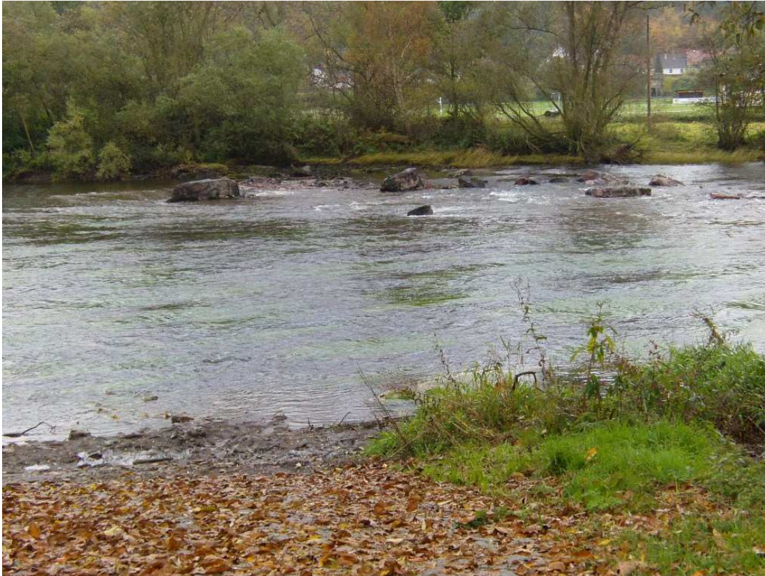
Abb. 15: Wehranlage Fischersdorf in der Saale nach Rückbau
