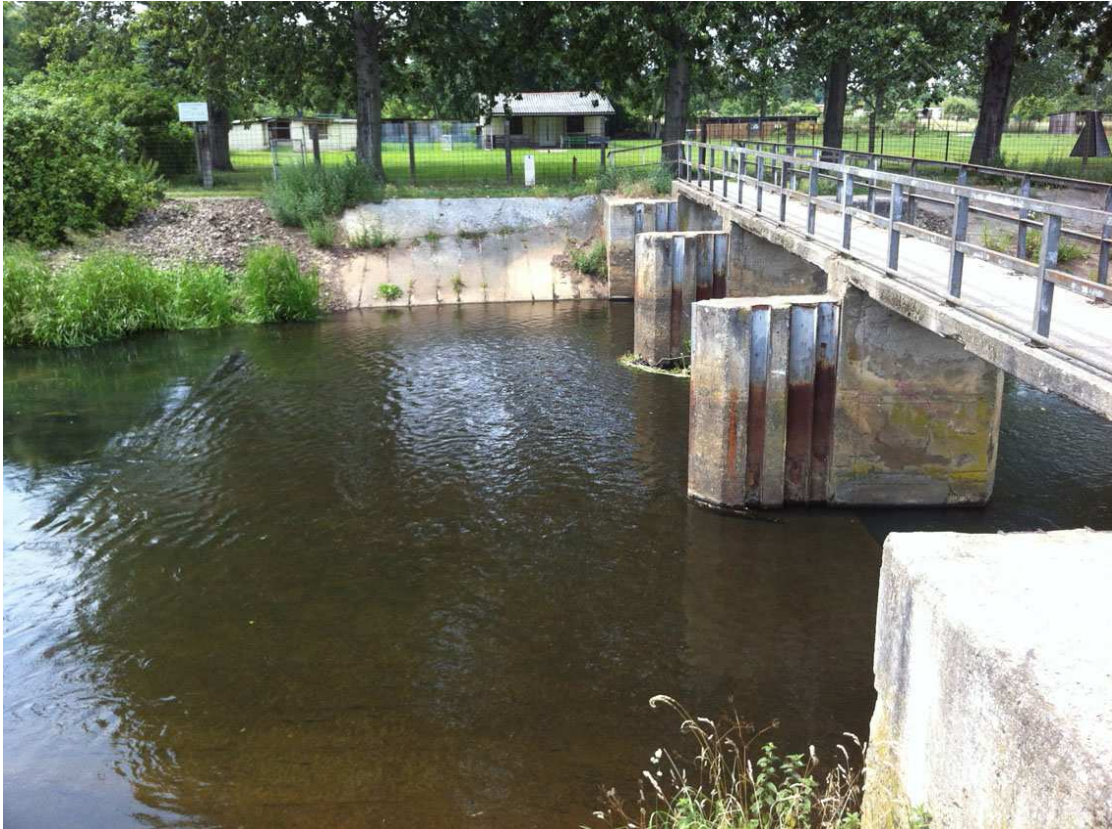
Abb. 11: Stauanlage der ehemaligen Zuckerfabrik an der Jeetze in Salzwedel – vor Beginn der Maßnahme
