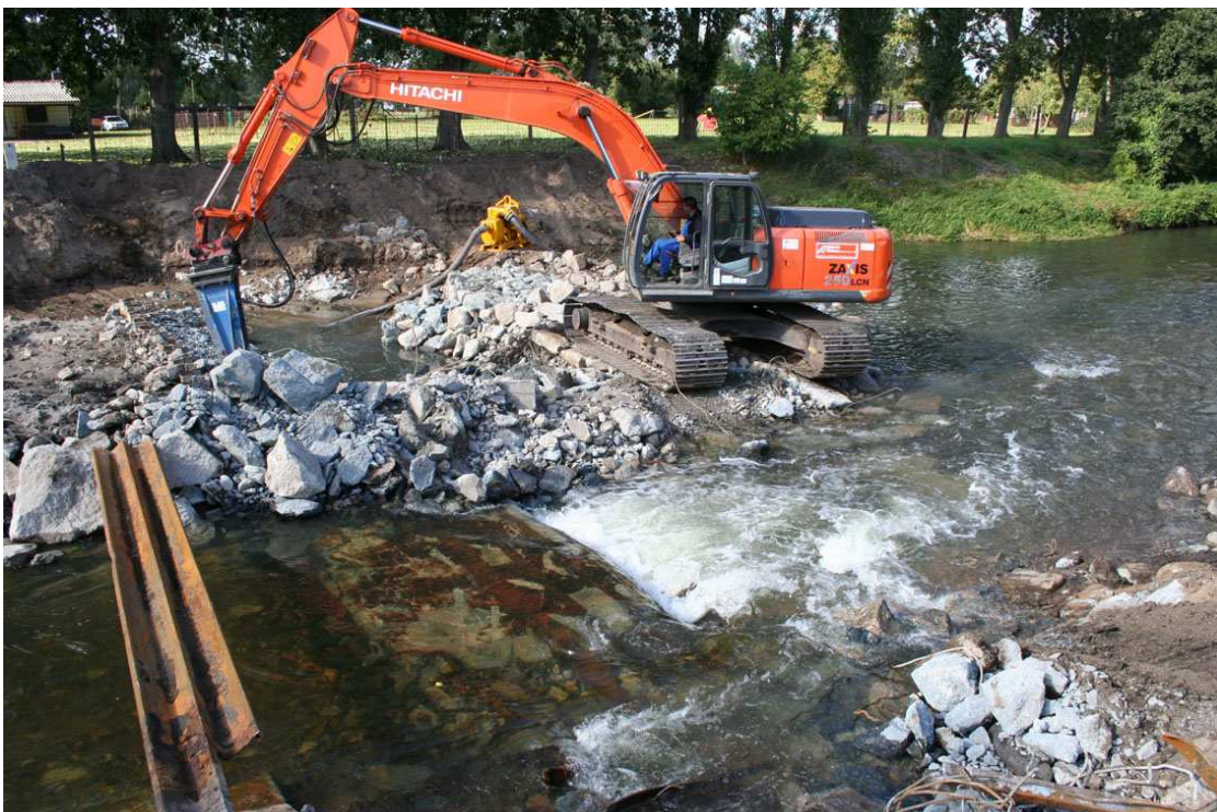
Abb. 12: Stauanlage der ehemaligen Zuckerfabrik an der Jeetze in Salzwedel – Rückbauphase
