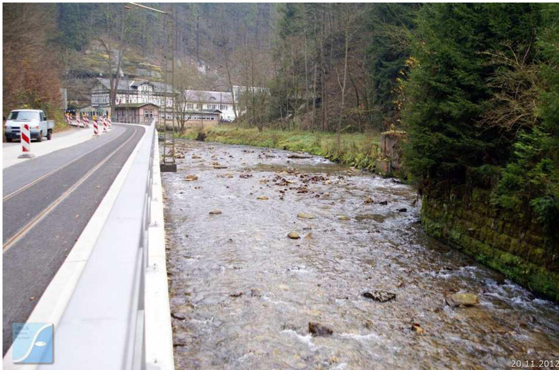
Abb. 8: Kirnitzsch Wehr Haidemühle – Ansicht nach Rückbau 2012
