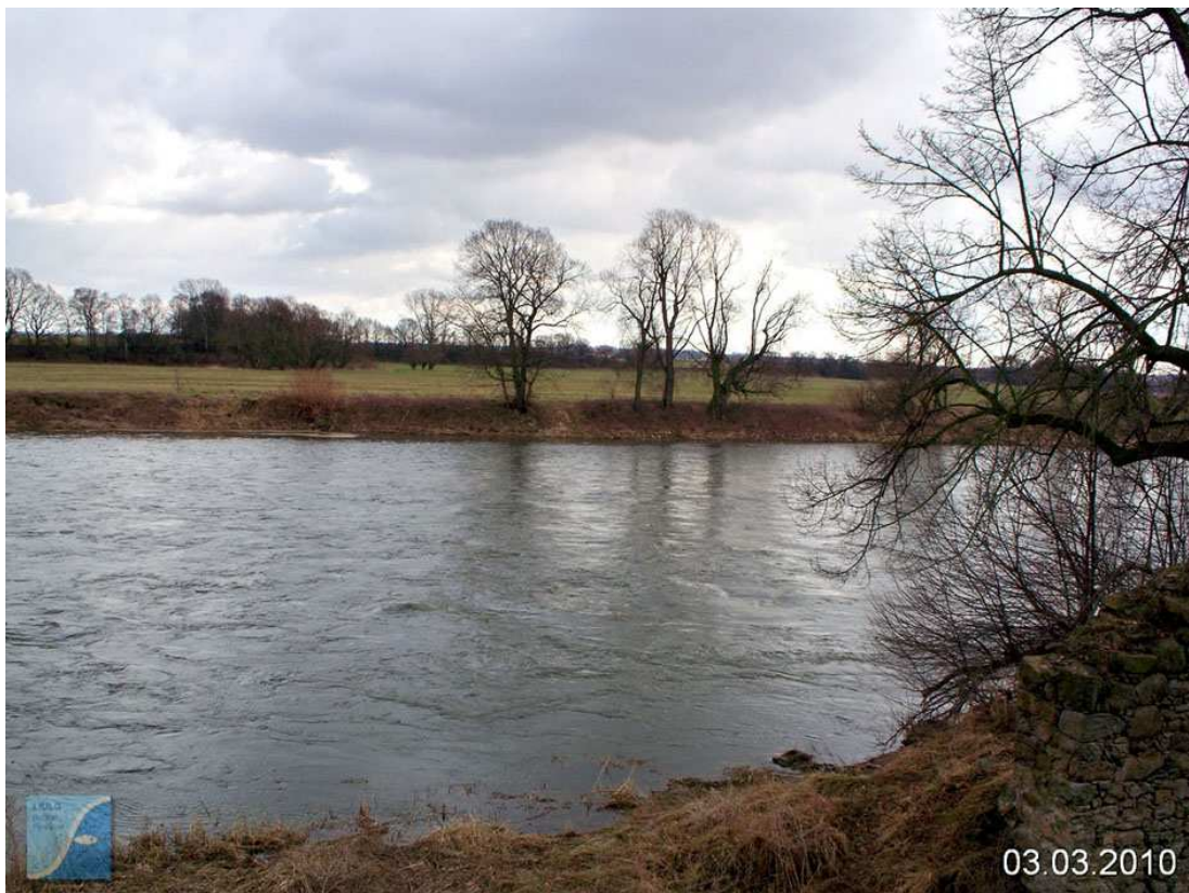
Abb. 10: Mulde Wehr Walzig – Seitenansicht nach Rückbau 2010
