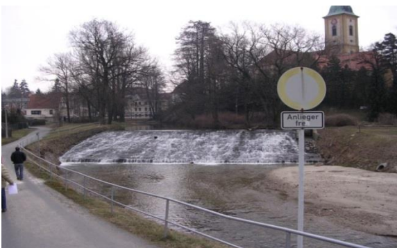
Abbildung 5.3 Beispiel für ein umgebautes Querbauwerk in Sachsen: Kirchwehr Prießnitz vor und nach dem Umbau (Foto: Sächsischer Staatsbetrieb Landestalsperrenverwaltung)
