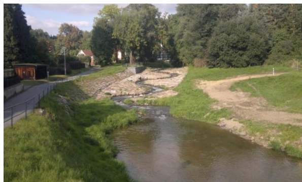
Abbildung 5.3 Beispiel für ein umgebautes Querbauwerk in Sachsen: Kirchwehr Prießnitz vor und nach dem Umbau (Foto: Sächsischer Staatsbetrieb Landestalsperrenverwaltung)
