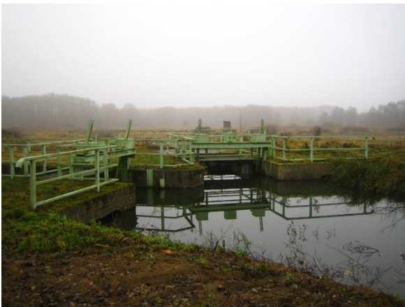
Abbildung 5.2 Beispiel M-V: vor und nach der Maßnahme Verteilerbauwerk mit zwei Wehren und FAA-Umgehungsgerinne (Foto: StALU Mittleres Mecklenburg)
