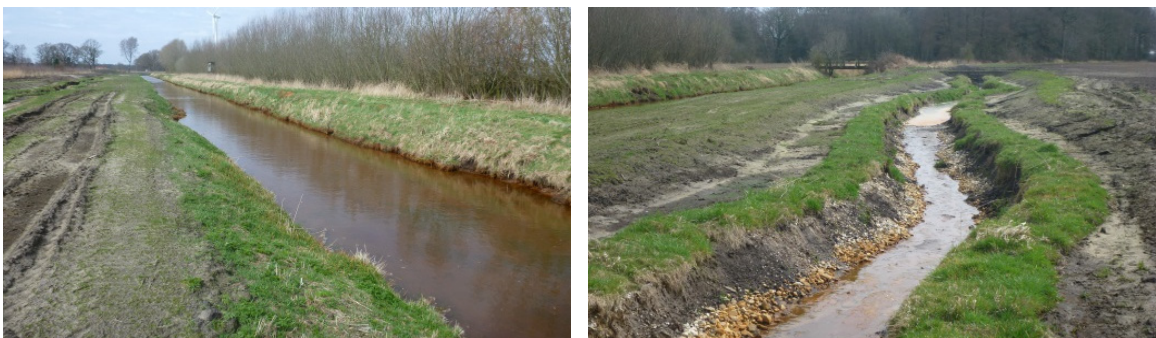
Abb. 5.6: Bau eines naturnahen Nebengerinnes entlang der Melstruper Beeke bei Lathen im Landkreis Emsland (links: altes Gewässerbett, das für den Hochwasserabfluss erhalten bleibt; rechts: Nebengerinne kurz nach Abschluss der Baumaßnahme) (Quelle: NLWKN)
