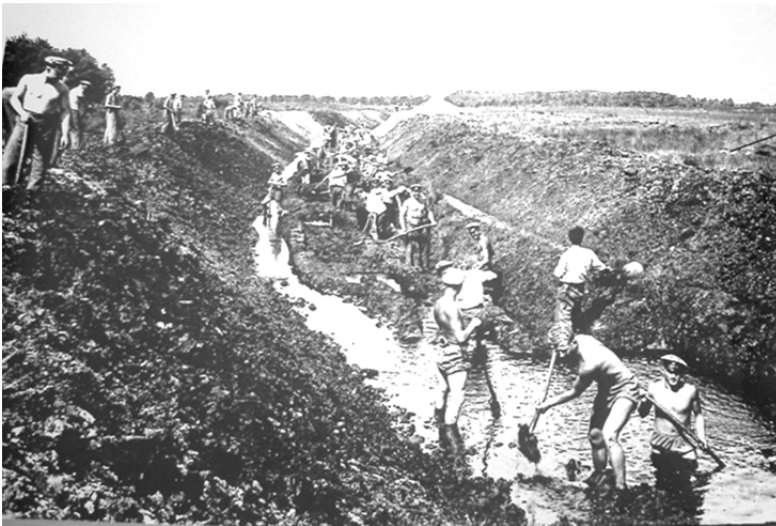
Abb. 1.6: Grabenbau mit dem Reichsarbeitsdienst im Jahre 1937
