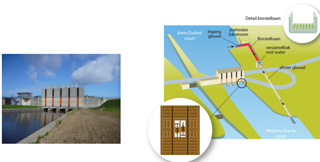
Abb. 5.9: Fischwanderhilfen zur Verbesserung der Durchgängigkeit des Schleusenkomplexes Nieuwe Stanzij (Quelle: Waterschap Hunze en Aa's)
