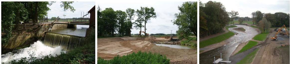
Abb. 5.8: Umbau des Schützenhofwehres Quakenbrück in eine Sohlgleite: Wehr vor dem Umbau (links), während der Bauphase (Mitte) und nach dem Umbau (rechts) (Quelle: NLWKN)
