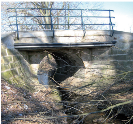
Salzbachbrücke - bestehend Querschnitt 2,5 m Dm.
