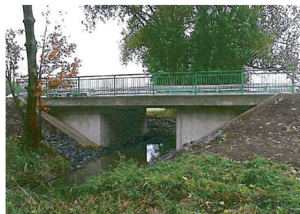
Salzbachbrücke - künftige Allerbrücke nach Querschnittsaufweitung 5,0 m
