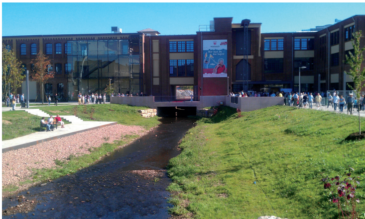
2. Bauabschnitt mit Blick auf die Stockwerkshalle
