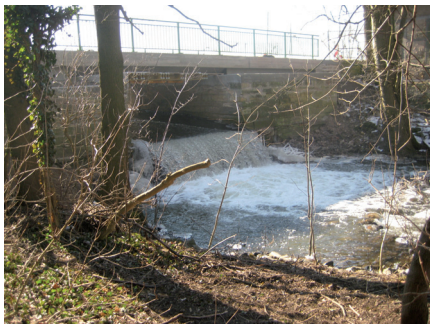
Absturzbauwerk Aller - Groß Bartensleben
