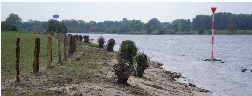
Bereich der vorgelagerten Halbinsel nach Abschluss der Bauarbeiten
