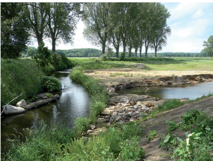
Rodenberger Aue nach der Umbaumaßnahme
