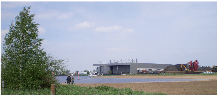
Naturstrand nach Abschluss der Bauarbeiten
