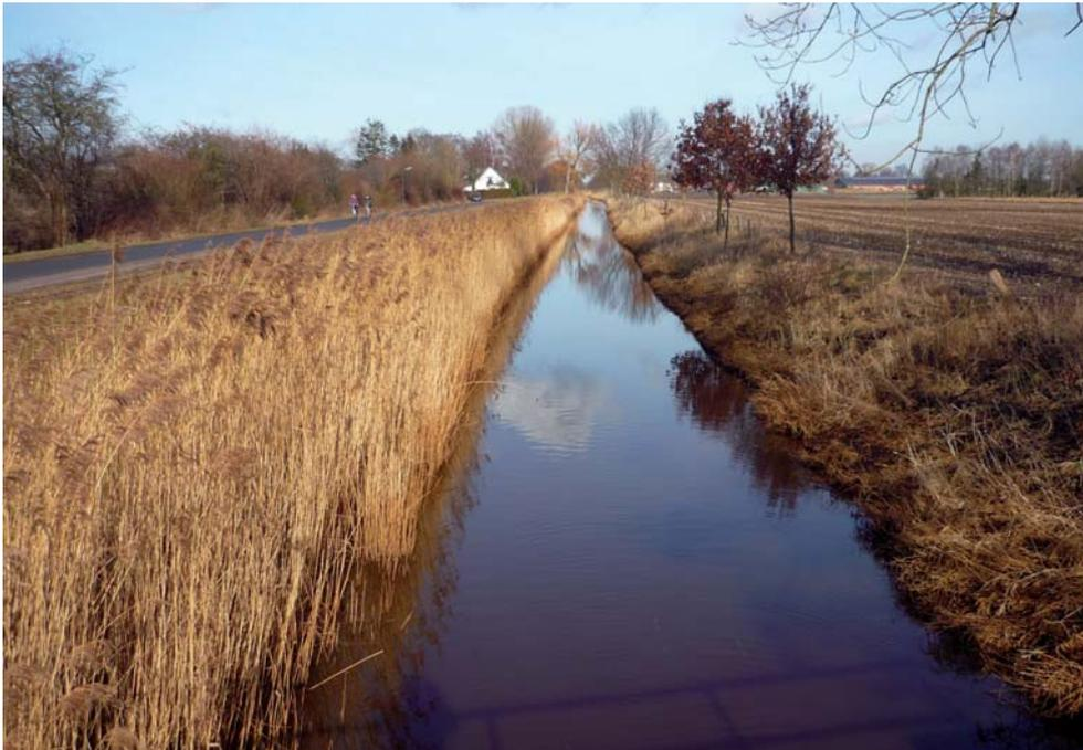
*Abb. 43: Deichschlot. Naturferne Lauf- und Profilausprägung. Aufgrund der Nutzung kaum Maßnahmenflächen verfügbar. Empfohlen werden Verbesserungen im Uferbereich (LAWA Nr. 73): Förderung standorttypischer Auegehölze aus Eigenansaat. Auetytische Vegetation ansiedeln, Nadelhölzer aus der Aue entfernen; Ausweisung eines ungenutzten Randstreifens wo möglich.*
