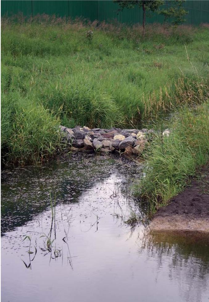
Abb. 32: Durch Abtrennung mit Wasserbausteinen wird der alte Verlauf des Embser Mühlengrabens oberhalb Bultensee zum Altgewässer.
