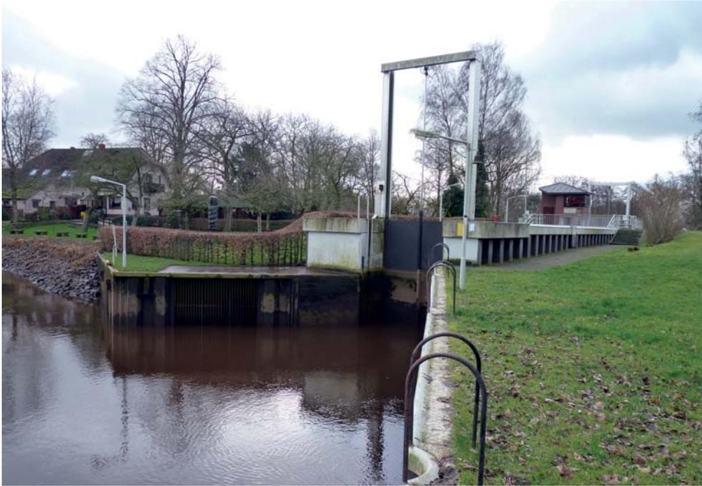
Abb. 45: Damsziel an der Mündung der Kleinen Wümme in die Wümme. Ziel: Anpassung des Schleusenmanagements für eine Verbesserung der Durchgängigkeit für Fische. (Kleine Wümme ist ein Gewässer 2. Priorität)
